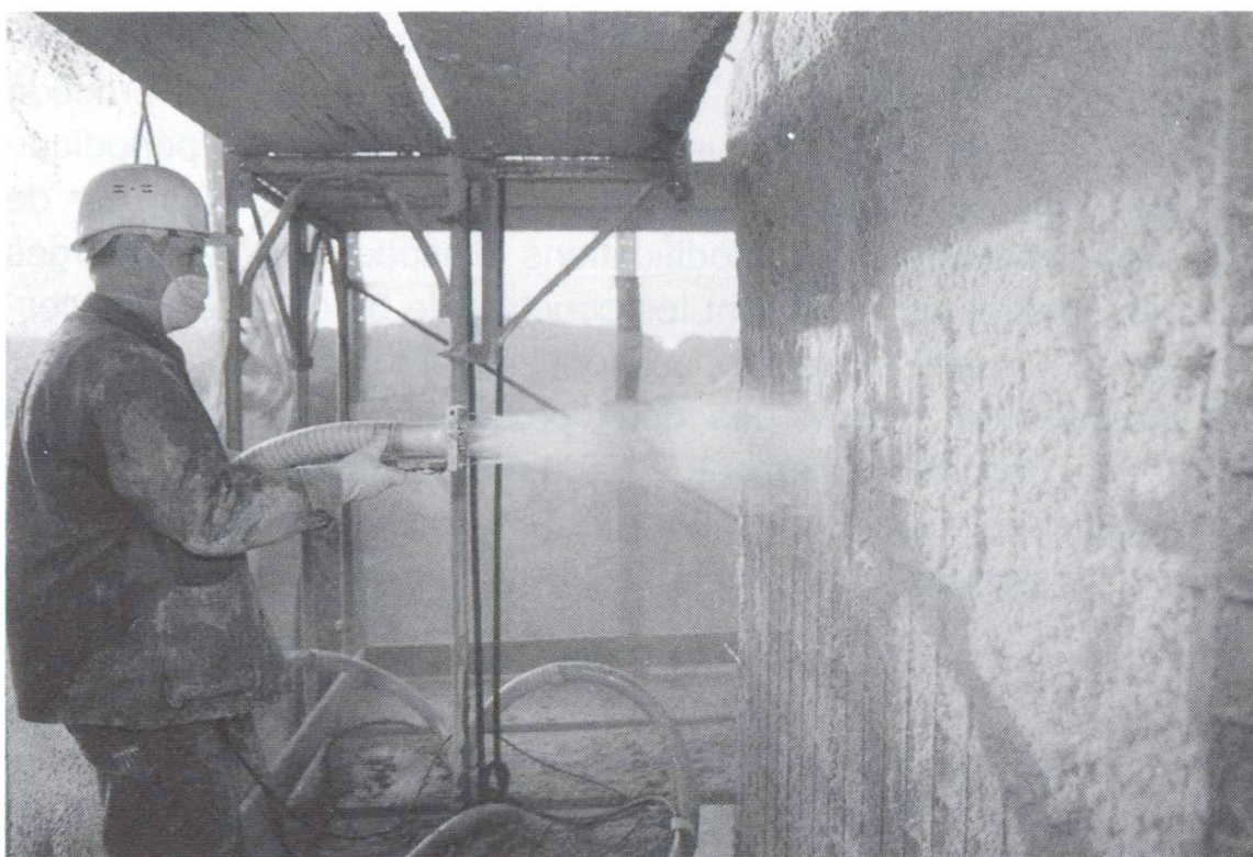
Recouvrement du treillis servant d'anode avec de la pâte de papier humide. (Photo: Ecbis, Allschwil)
