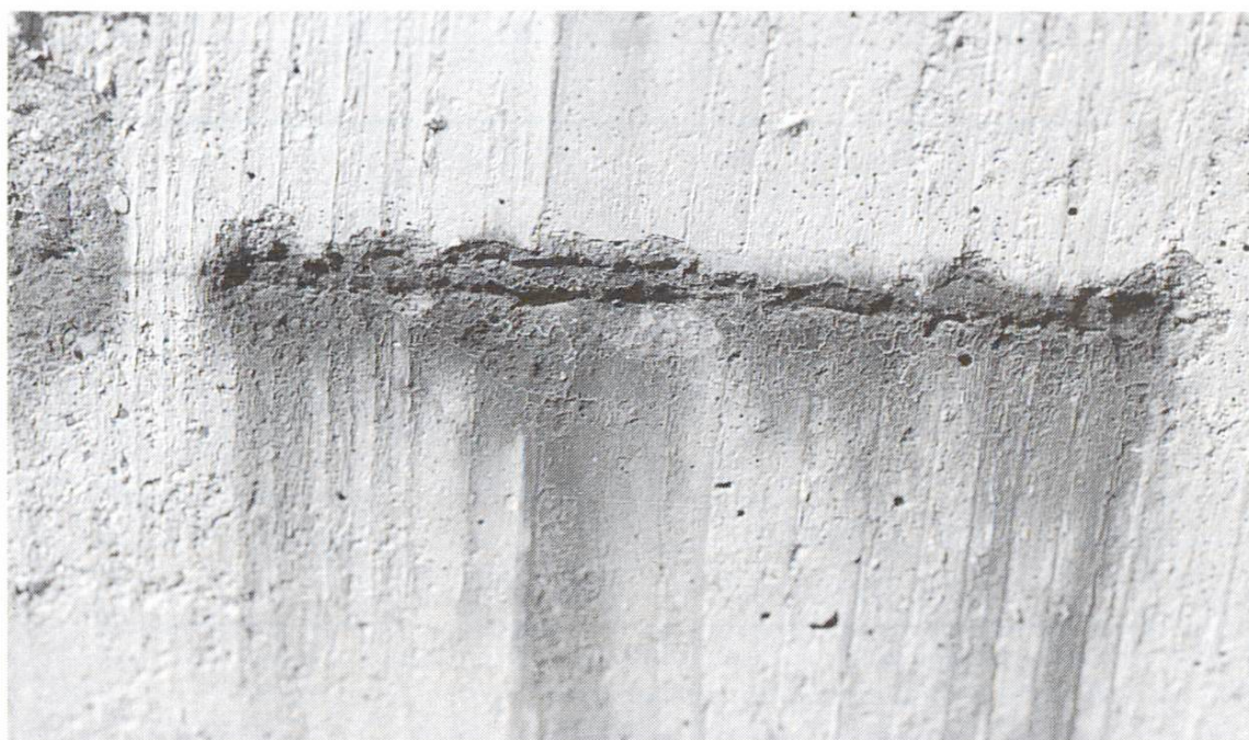
Eclatements résultant de la corrosion de l'armature.
