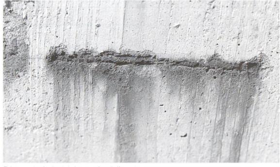
Eclatements résultant de la corrosion de l'armature.
