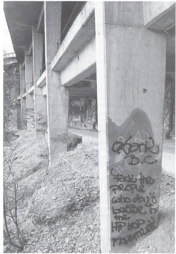
Sous la place de la gare de Baden: Des endroits non étanches sur la face supérieure de cet ouvrage de plusieurs étages ont entraîné la pénétration d'eau chlorurée, qui a provoqué d'importants dégâts de corrosion dans les piliers photographiés. La protection cathodique a permis de réparer ces dégâts sans modification de l'état structural des piliers (pas d'enlèvement de béton).
