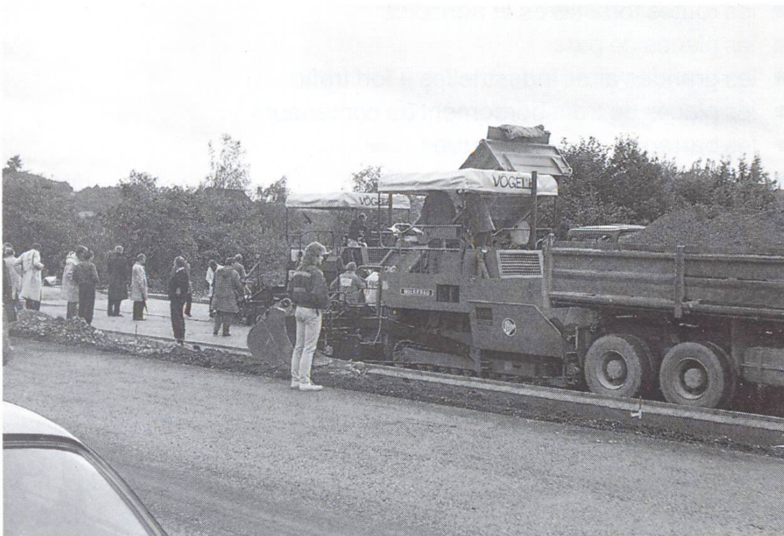
Camion basculant et finisseuse – pour le béton compacté, deux maillons importants de la chaîne de mise en place.
