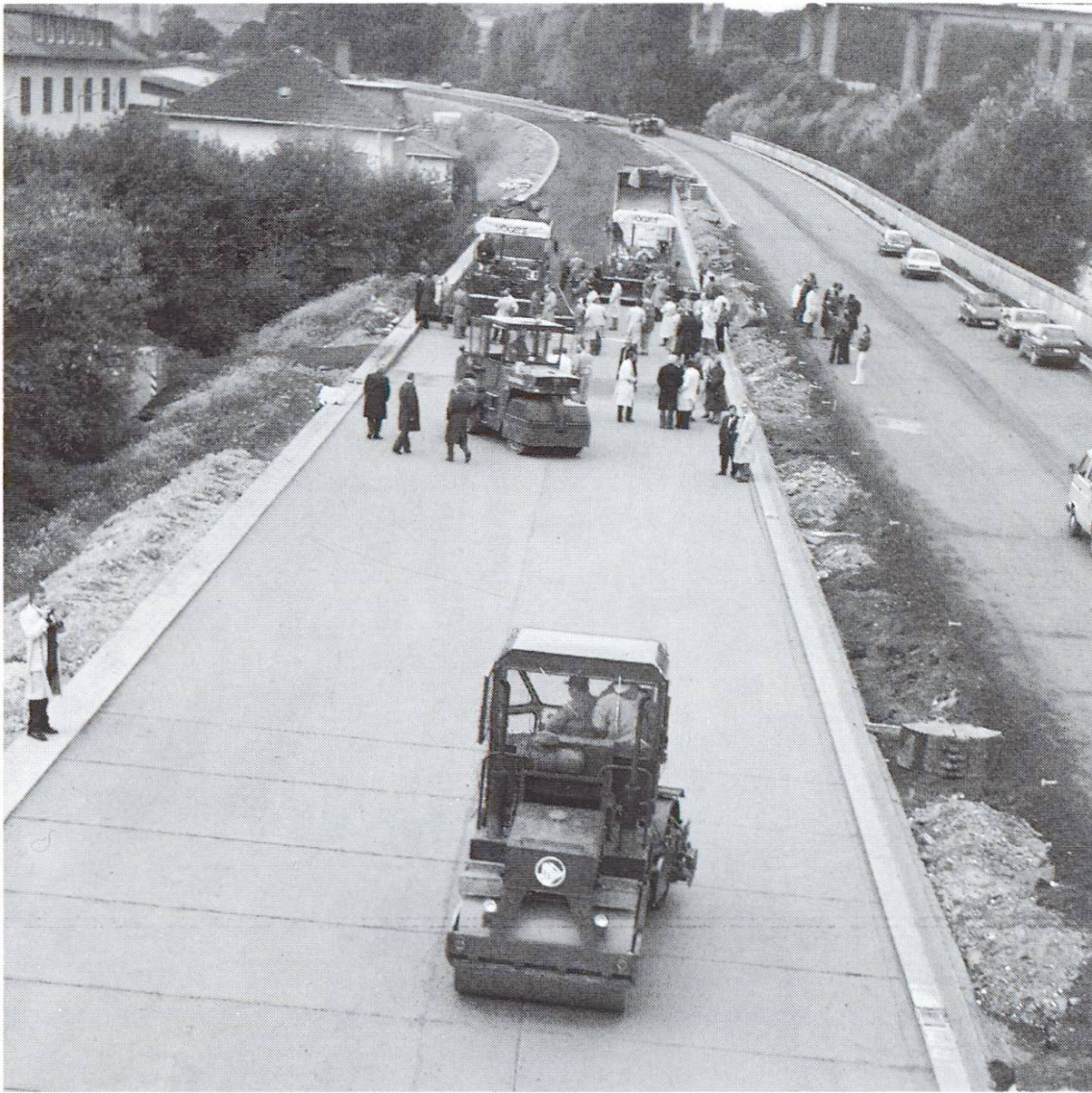
Béton compacté mis en place en double passe: le mélange de béton compacté amené avec des camions basculants est déversé dans la finisseuse, d'où il est mis en place et, finalement, compacté avec des rouleaux vibrants (vu de l'arrière).
