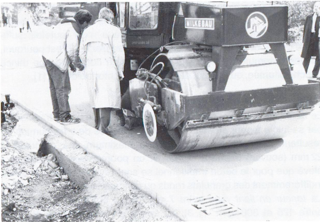
Compactage au rouleau vibrant du béton compacté.
