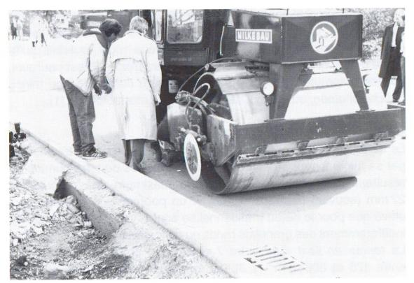
Compactage au rouleau vibrant du béton compacté.
