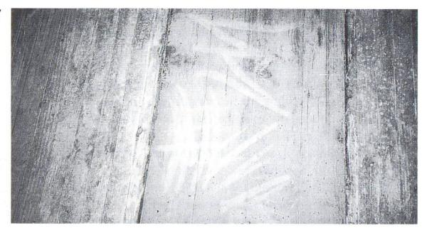
Appliqués en trop forte concentration, les produits de décoffrage peuvent provoquer le farinage ou le poudrage des surfaces de béton. (Photos: TFB)
