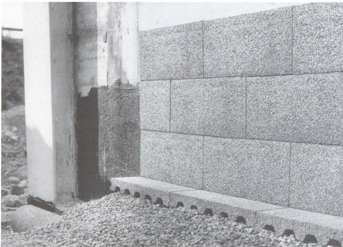
Mise en place de plaques filtrantes: une rangée de briques d'assise filtrantes posée sur une couche de gravier filtrant sert de base aux plaques filtrantes qui sont superposées le long du mur.
