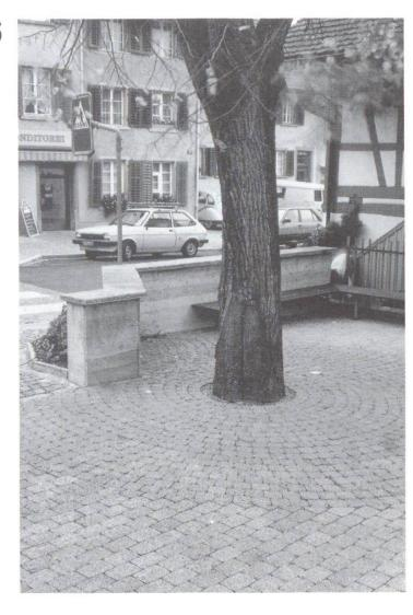
Des pavés en béton filtrant, perméables à l'eau et à l'air, stabilisent une surface de façon uniforme et durable, sans la sceller. (Photo: Hunziker-Baustoffwerke AG)
