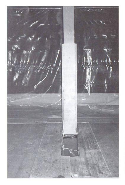
Exemple d'un coûteux recouvrement de protection contre l'eau: feuilles de PVC soudées contre les murs et le sol, à l'horizontale, protégées contre l'endommagement par des panneaux de coffrage.
