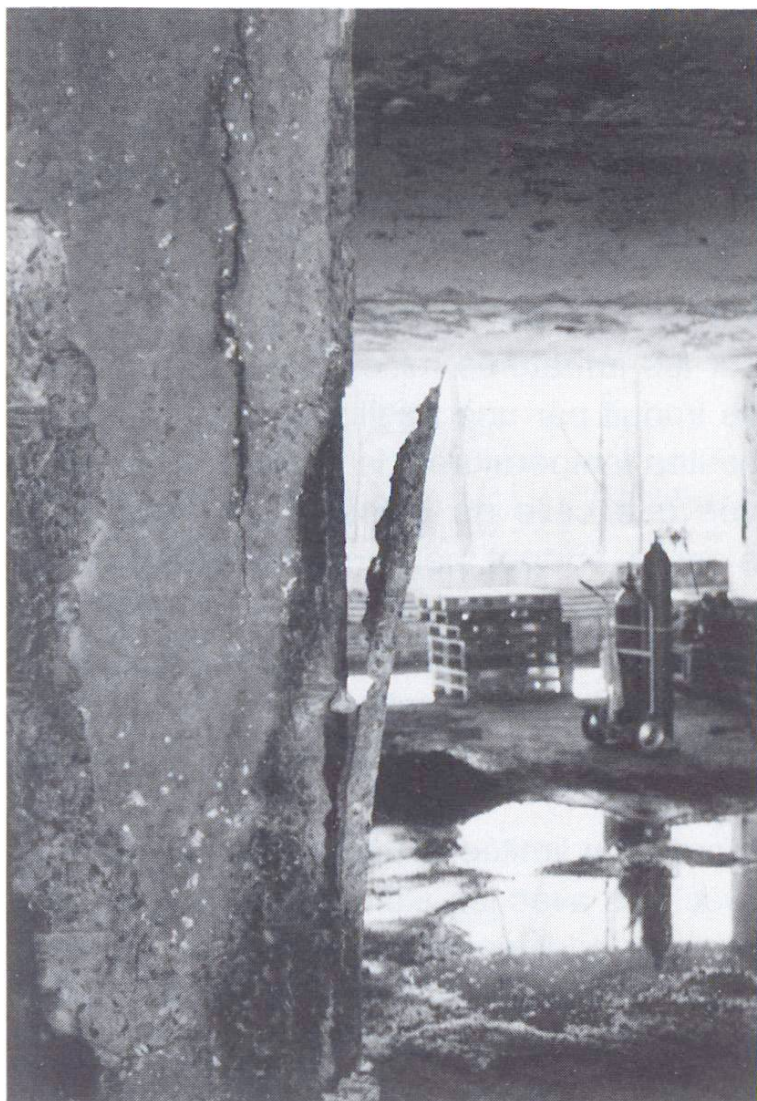
Fig. 4. Eclatement du béton sur un pilier incendié.
