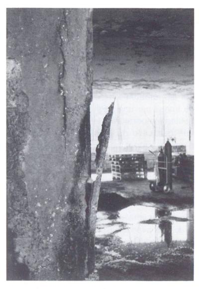
Fig. 4. Eclatement du béton sur un pilier incendié.
