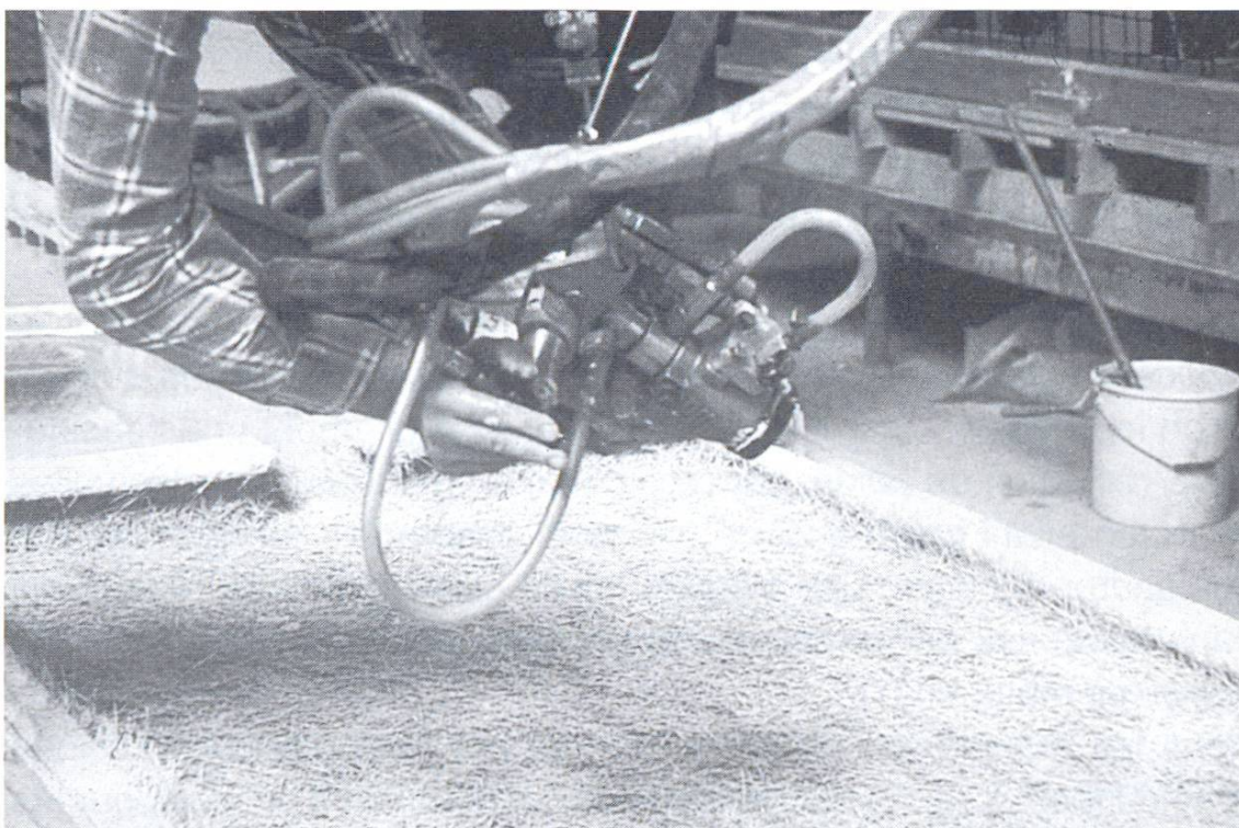
Mise en œuvre de béton de fibres de verre par projection.
