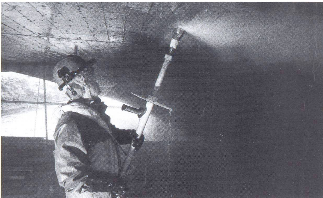
Fig. 2 Nettoyage d'un dessous de pont au moyen d'une lance à main (1000 bars). On remarque les nombreuses mesures prises pour protéger l'opérateur.
