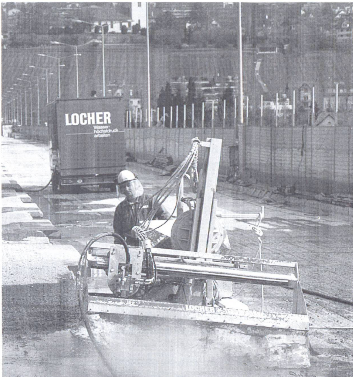
Fig. 4 Démolition du béton sur surface horizontale au moyen d'un appareil à jet d'eau sous très haute pression commandé par robot (pression 1000 bars, flux volumique 138 l/min).
