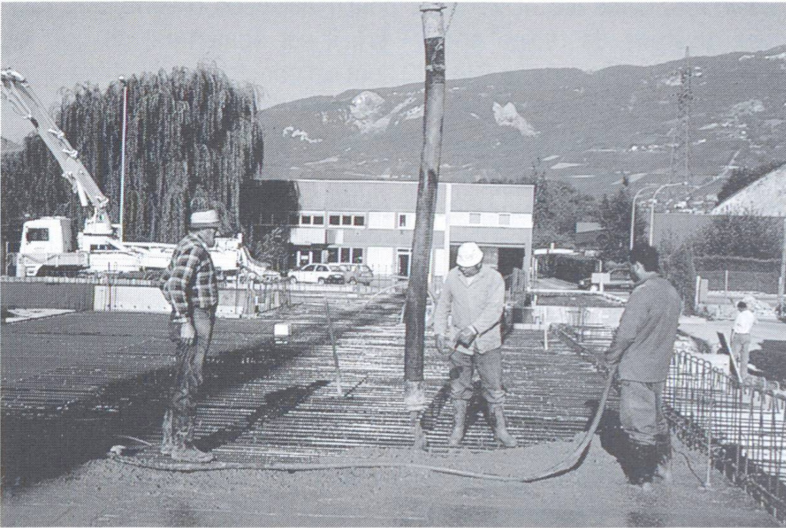
Bétonnage de la dalle de fond dans une fromagerie. Avec les armatures revêtues, la mise en place du béton est la même que pour les armatures classiques. (photo: Von Roll)
