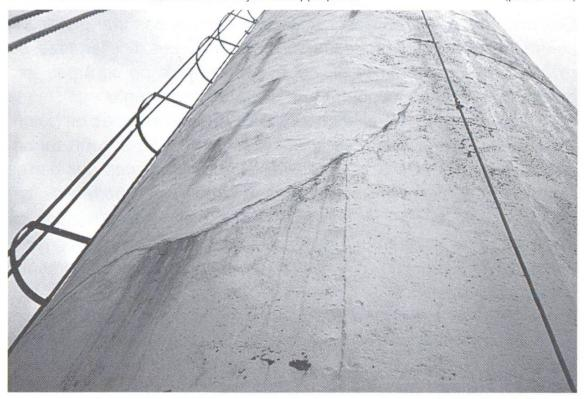
variations de température et d'humidité, ainsi que d'autres effets nuisibles, l'enrobage des barres d'armature passive sera de 20 mm au moins. Dans tous les autres cas, cet enrobage sera d'au moins 30 mm (surfaces coffrées) ou 35 mm (surfaces non coffrées).
