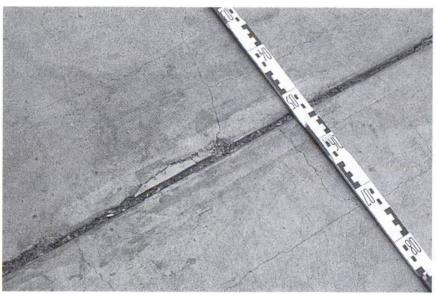
Fig. 4 Ecaillage le long d'un joint et fissuration verticalement au joint. Raison: contraintes de cisaillement plus élevées dans la zone des joints et passage de véhicules; faible adhérence et trop forte sollicitation.
