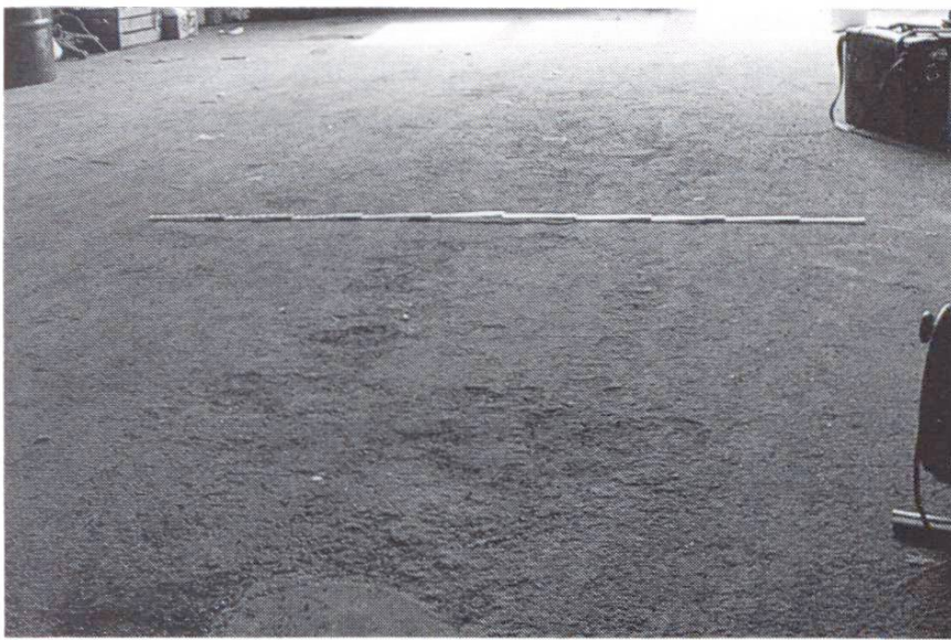
Fig.2 Chape en ciment d'un local artisanal dont la surface est fortement endommagée. Raison: groupe de sollicitations II et composition du matériau incorrecte.
