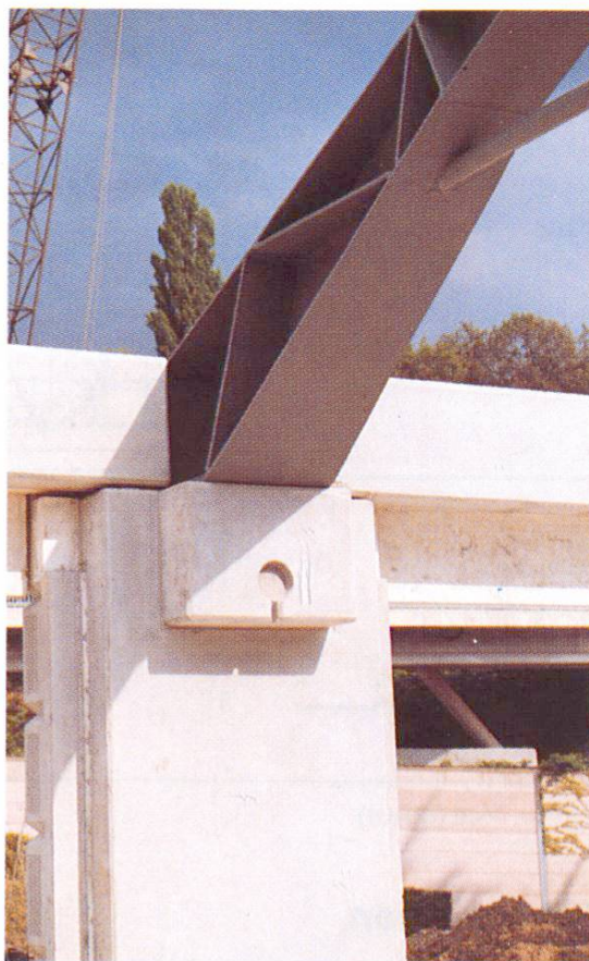
Fig. 7 Appui de la charpente métallique du toit
