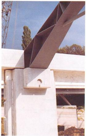
Fig. 7 Appui de la charpente métallique du toit
