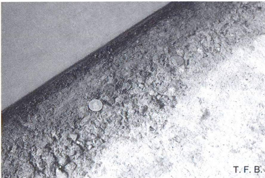
Fig. 9 Joint de reprise dans le béton dur. Il sera bétonné à fleur le jour suivant.
