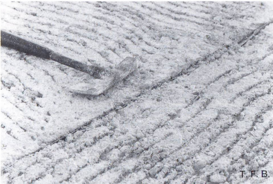
Fig. 8 Fond soigneusement préparé. Le joint de reprise est séparé au moyen de carton bitumé et peut être recouvert de béton dur. D'insignifiantes fissures capillaires peuvent à la rigueur apparaître.
