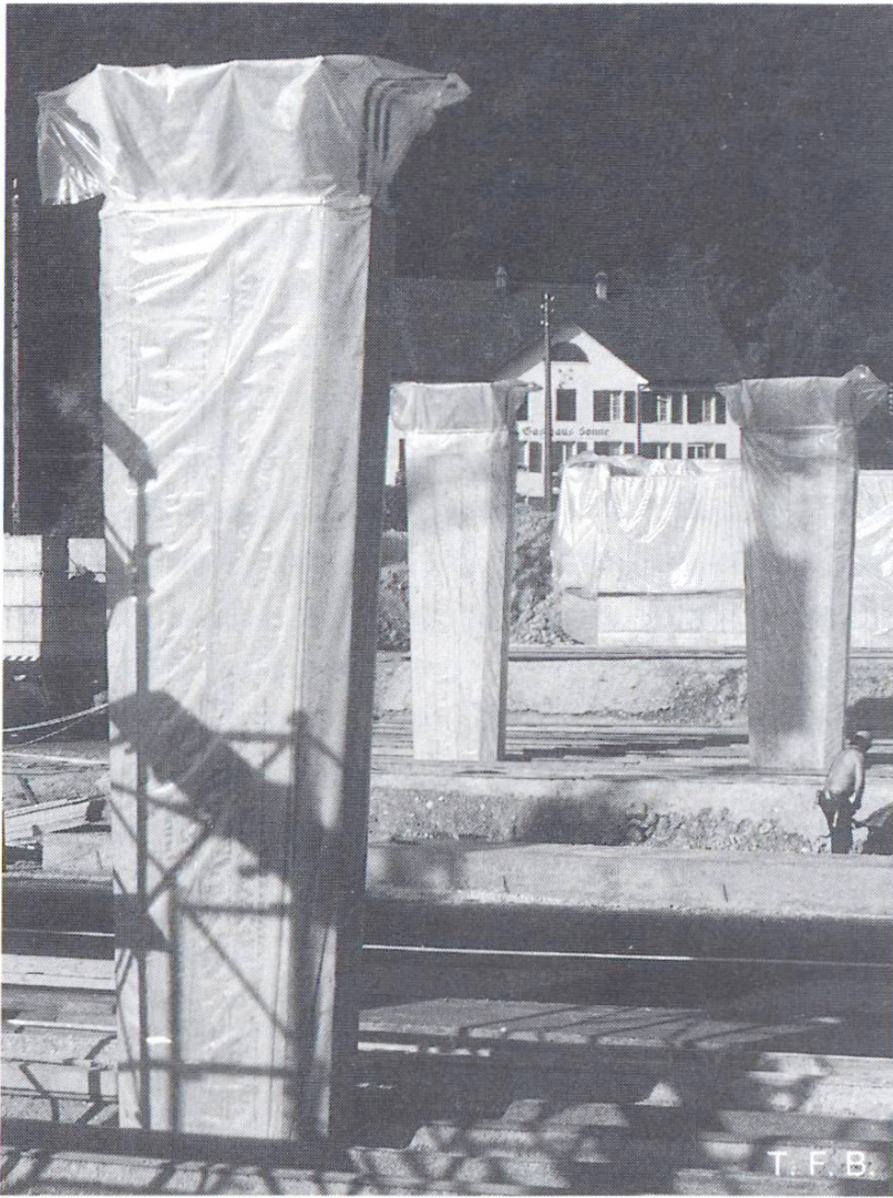
Fig. 2 Piles et culées d'un viaduc. Le béton est enveloppé de bâches en plastique servant au traitement de cure ainsi qu'à protéger la surface visible des marbrures de rouille des fers de reprise ou des efflorescences de chaux dues à l'eau de pluie (canton d'Argovie: pont K 364, juillet 1988).
