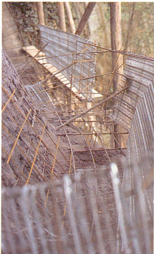
Fig. 6 Armature pour bacs à plantes
