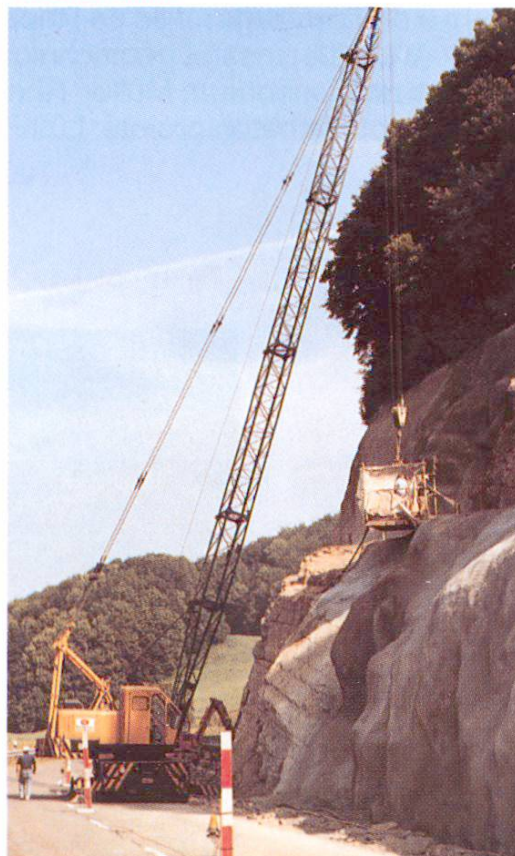
Fig. 14 Projection du béton depuis une nacelle volante
