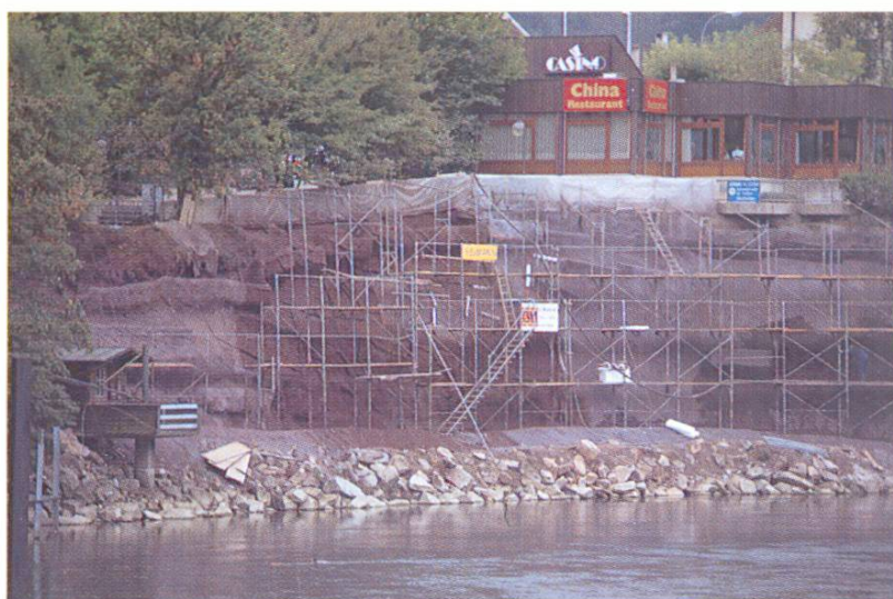
Fig. 10 Echafaudage pour la projection du béton
