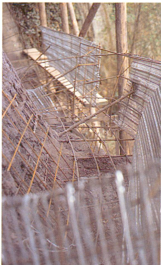
Fig. 6 Armature pour bacs à plantes
