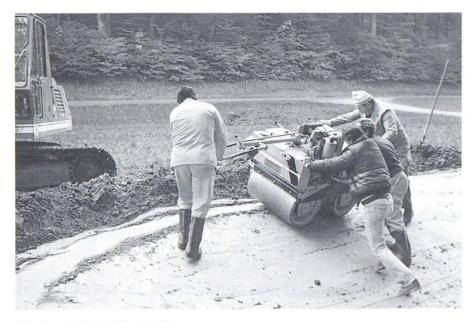
Fig. 15 Façonnage du bord
