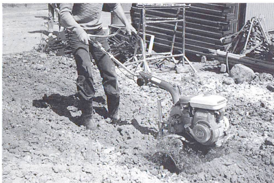
Fig. 12 Malaxage avec une tritreuse
