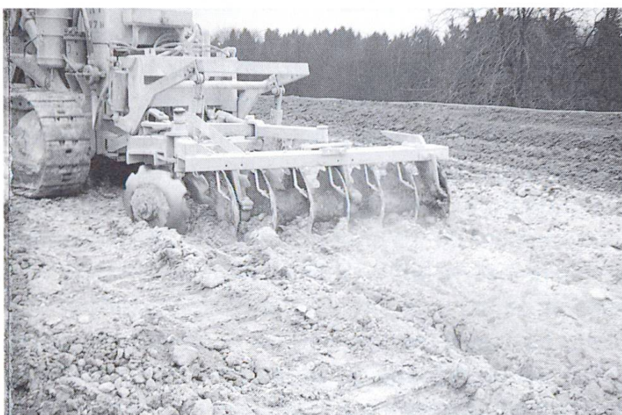
Fig. 13 Malaxage avec un pulvérisateur à disques
