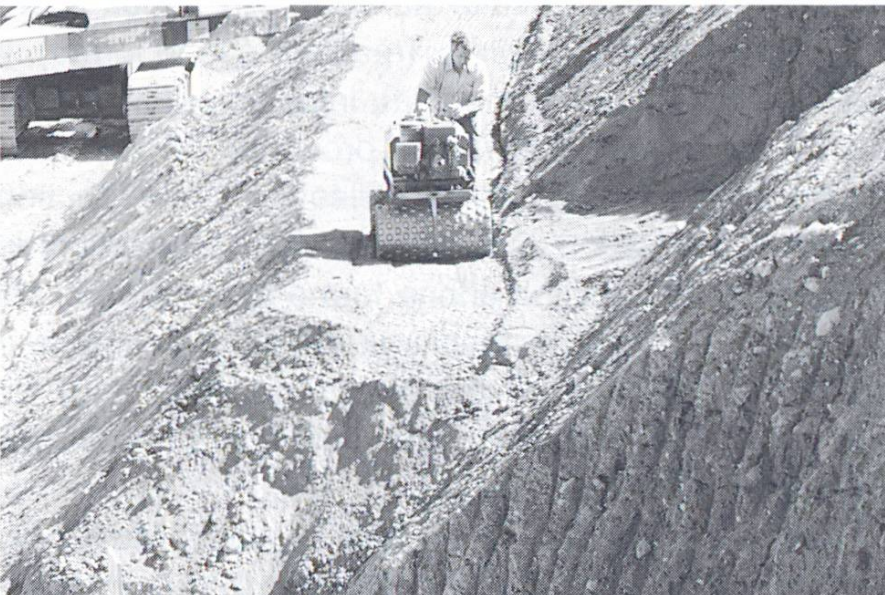
Fig. 16 Pour les berges escarpées, les couches sont mises en place horizontalement (travaux exécutés avec des bernes comme dans les grands chantiers)
