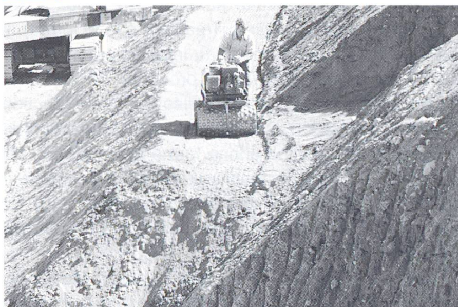
Fig. 16 Pour les berges escarpées, les couches sont mises en place horizontalement (travaux exécutés avec des bennes comme dans les grands chantiers)
