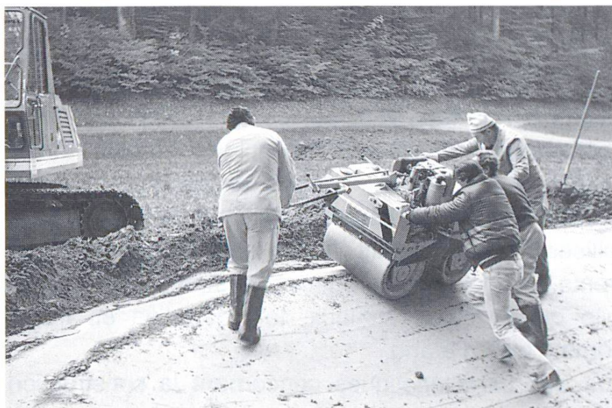
Fig. 15 Façonnage du bord
