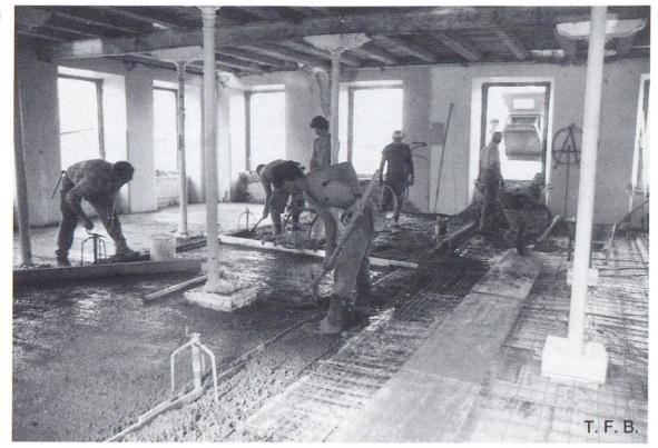
Fig. 9 Transport du béton par benne de grue depuis l'engin de manutention. Entrée par les fenêtres latérales, puis transport à la brouette et mise en place
