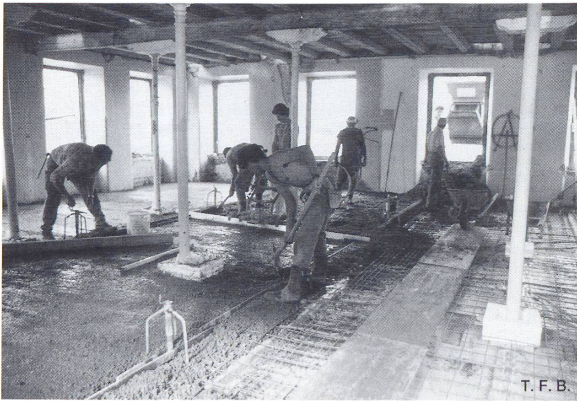
Fig. 9 Transport du béton par benne de grue depuis l'engin de manutention. Entrée par les fenêtres latérales, puis transport à la brouette et mise en place
