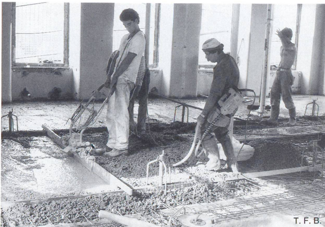
Fig. 10 Précompactage avec vibreur Ø 30 mm, vibrage avec règle vibrante
