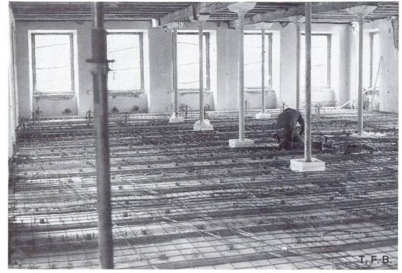
Fig. 6 Plancher sur sous-sol préparé pour le bétonnage. Poutres continues sur trois travées (de gauche à droite)
