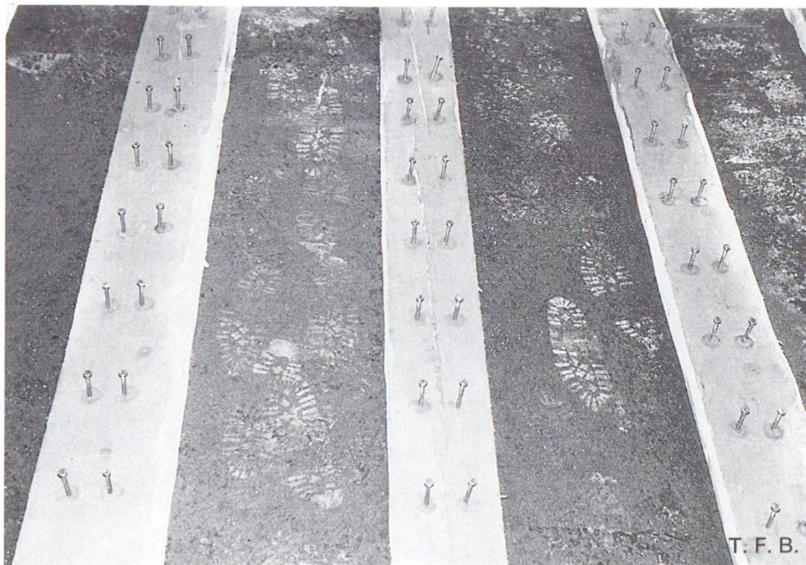
Fig. 5 Structure encore avec des clous. Exemple datant de 1967/68. Dans ce bâtiment, on a utilisé du béton léger
