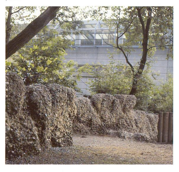
2 De 1985 à 1989, le zoo de Zurich a fait améliorer quelques-uns de ses enclos et construire un nouveau bâtiment central. Pour répondre à des exigences d'ordre fonctionnel et esthétique, on a utilisé du béton pour la réalisation de roches de poudingue. Ce mode de construction, applicable au besoin ailleurs également, donne l'occasion de traiter du problème de la construction dans un zoo.
