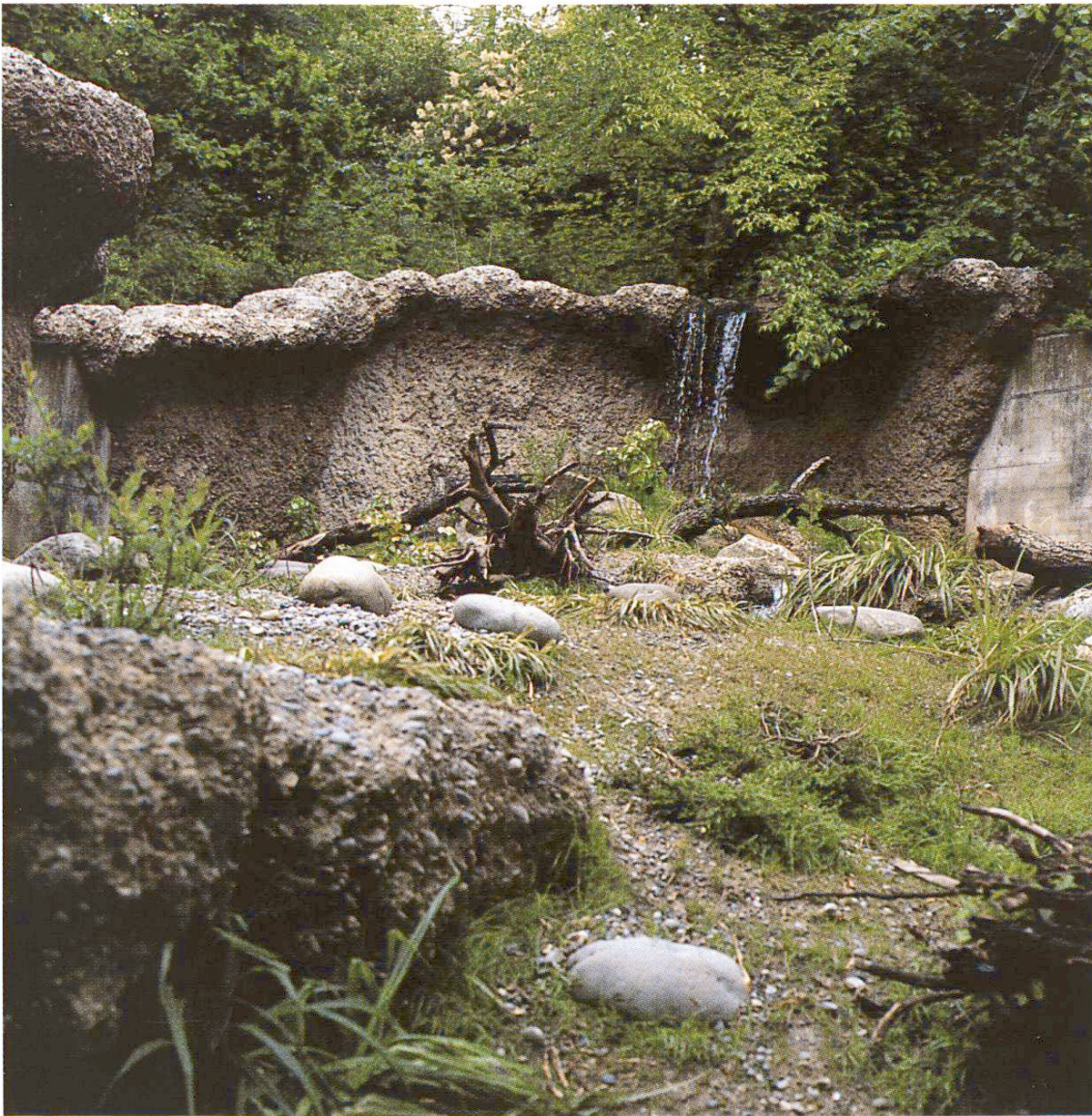
Fig. 2 Mur de fermeture avec surplomb en empêchant le franchissement (enclos des loutres).
