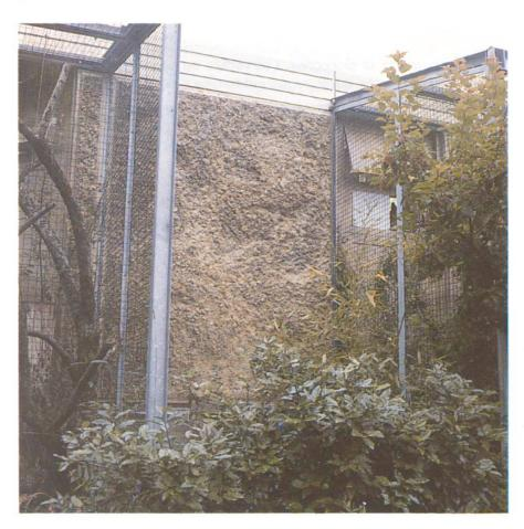
9 de sable grossier. Sa coloration provient en partie des galets et en partie du liant. En traitant le béton de la façon voulue, on obtient un aspect similaire, et donc le poudingue artificiel.
