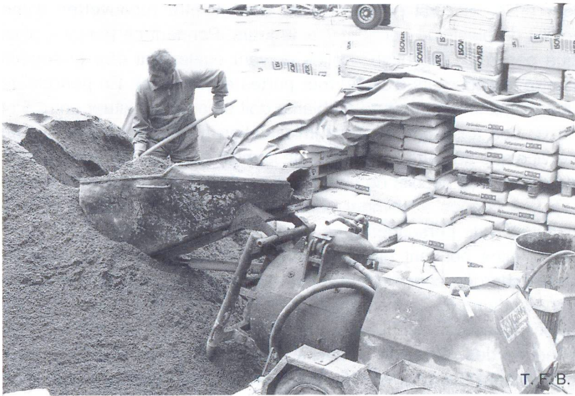
Fig. 2 Mélange du mortier et pompage au lieu de la mise en place.
