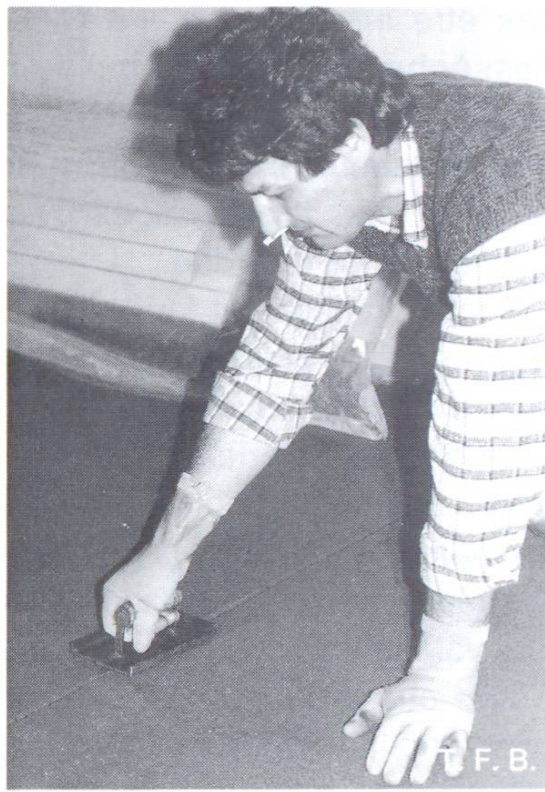
Fig. 5 Exécution d'un joint de retrait avec le fer à joints. La chape n'est pas découpée sur toute la hauteur.
