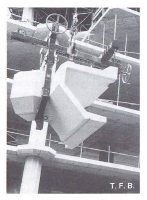
Fig. 6 Engin auxiliaire servant à stabiliser le centre de gravité de l'élément dans le prolongement du câble de levage
