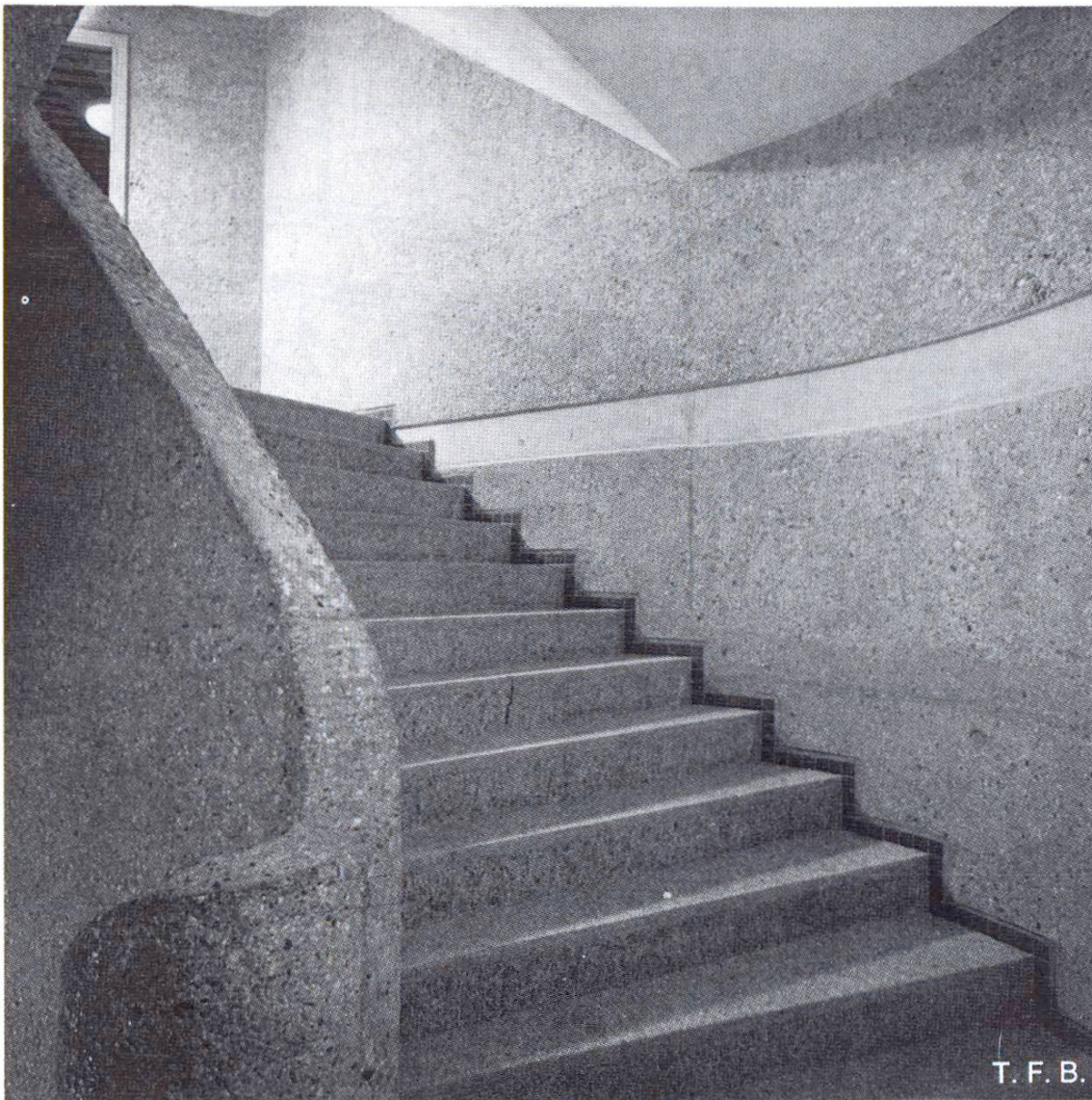
Fig. 7 Béton apparent dans la cage d'escalier
