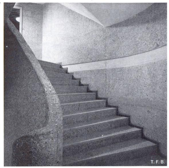
Fig. 7 Béton apparent dans la cage d'escalier
