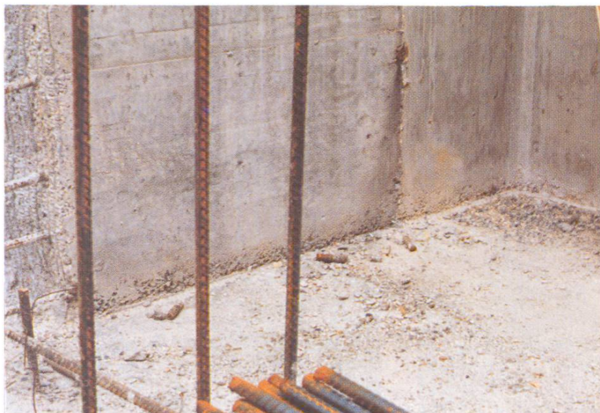
Fig. 7 Raccord mural intérieur.
