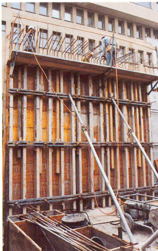
Fig. 4 Coffrage mural, d'environ 4 m de hauteur.
