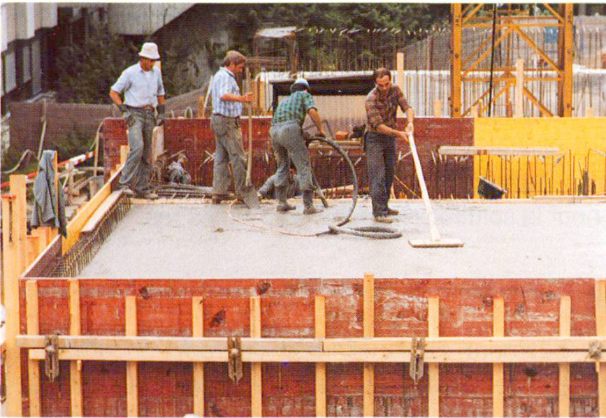
Fig. 12 Achèvement des travaux de bétonnage de la dalle.
