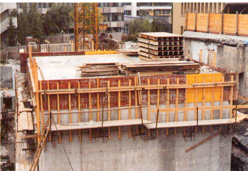
Fig. 14 Humidité maintenue par arrosage continu pendant 7 jours.
