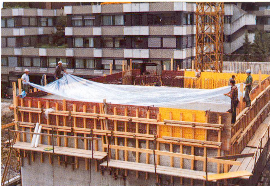
Fig. 13 Recouvrement avec une bâche en plastique.
