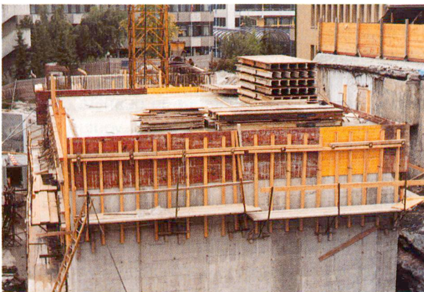
Fig. 14 Humidité maintenue par arrosage continu pendant 7 jours.
