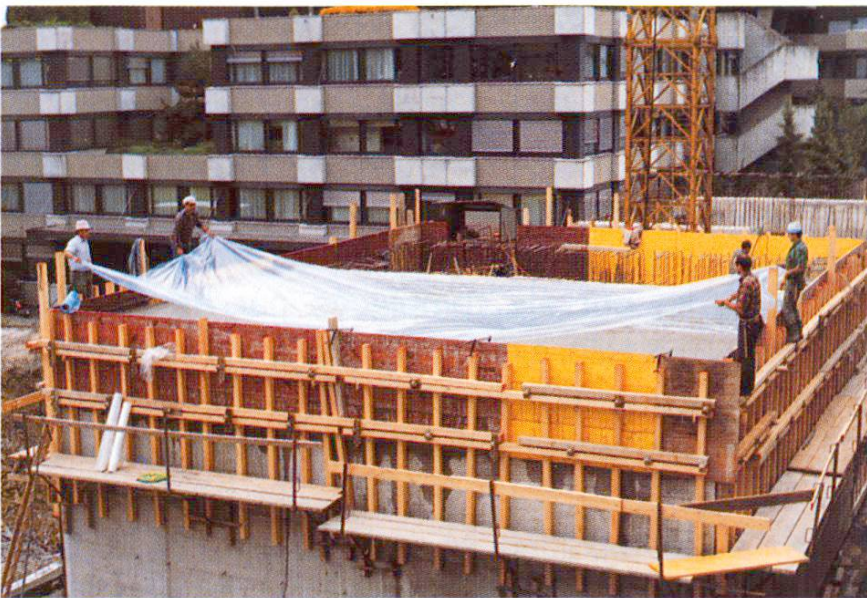
Fig. 13 Recouvrement avec une bâche en plastique.
