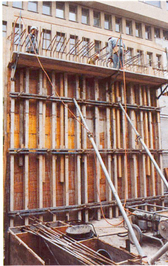
Fig. 4 Coffrage mural, d'environ 4 m de hauteur.
