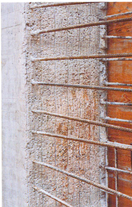
Fig. 3 Joint de reprise. Le métal déployé est enlevé et nettoyé.
