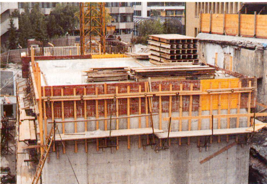
Fig. 14 Humidité maintenue par arrosage continu pendant 7 jours.
