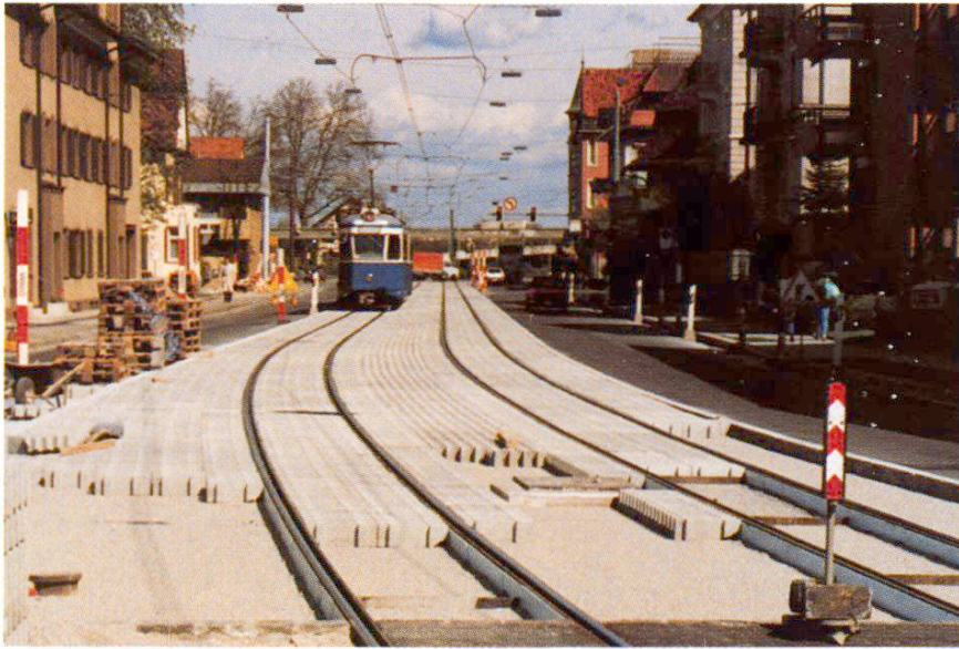
Fig. 8 Voie de tram qui sera gazonnée. Forte atténuation du bruit.
