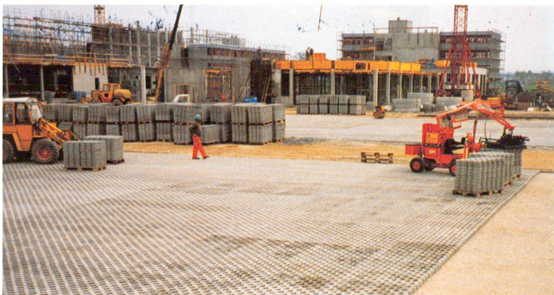
Fig. 4 Pose des dalles alvéolées: à la machine pour les grandes surfaces.
