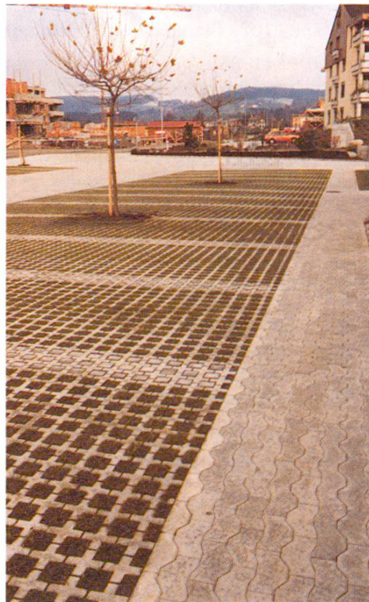
Fig. 3 Marquage des cases de parking par remplissage des alvéoles.
