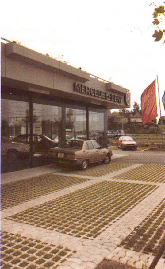
Fig. 2 Marquage des cases de parking par des pavés.
