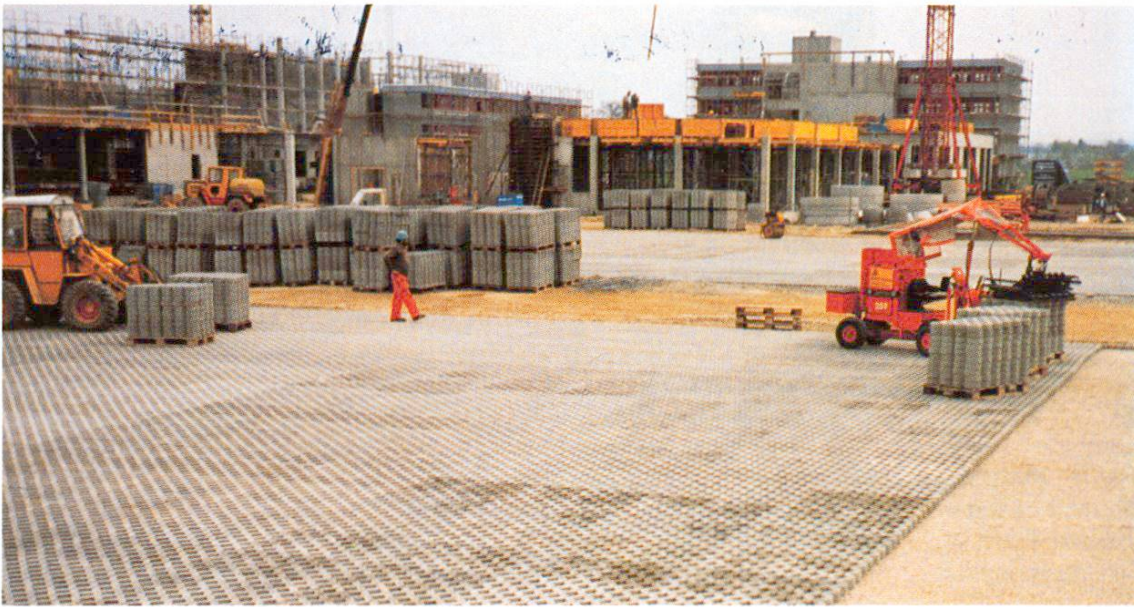
Fig. 4 Pose des dalles alvéolées: à la machine pour les grandes surfaces.
