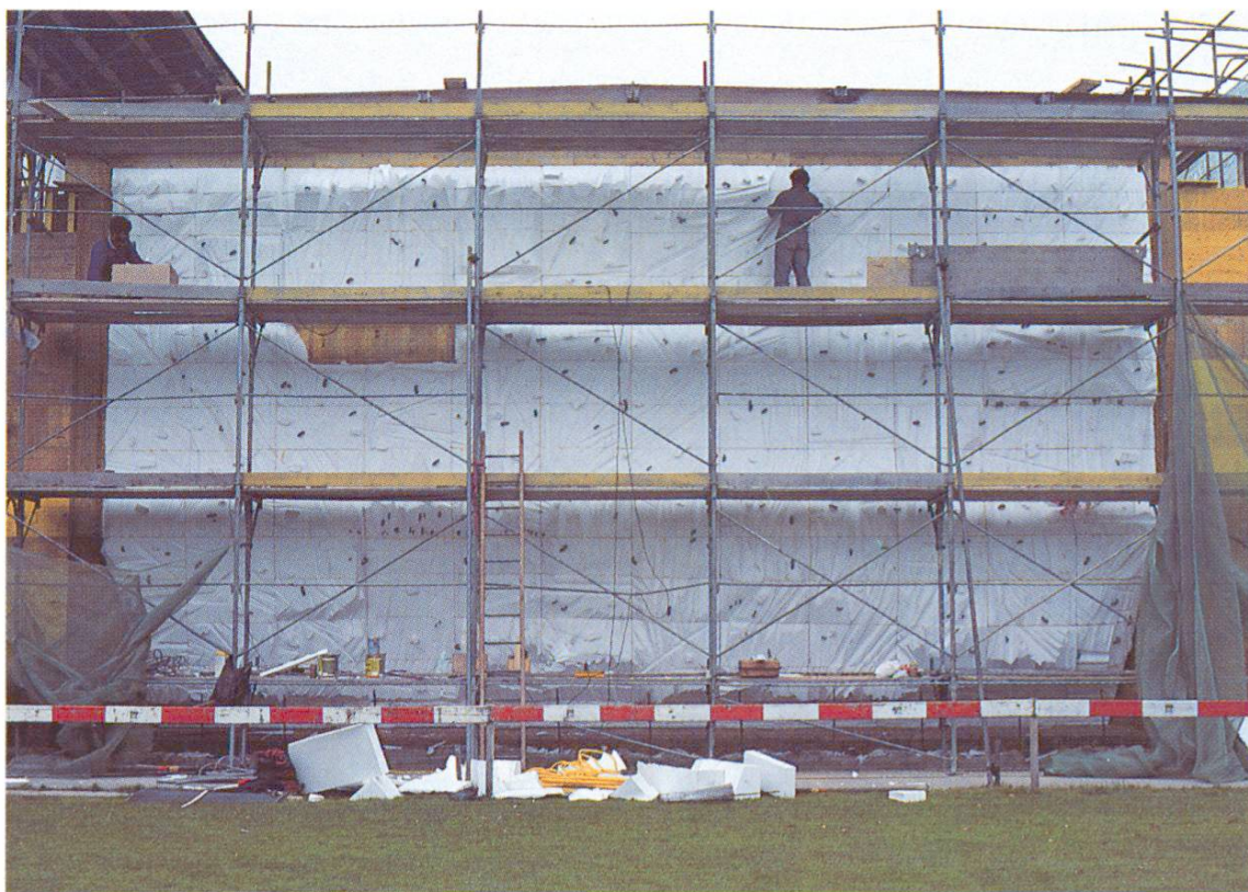
Coffrage intérieur avec blocs modelés, avant la pose de l'armature et du coffrage extérieur (Berne-Neufeld).
