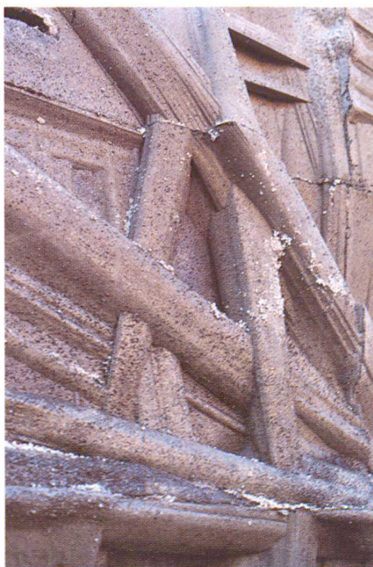
Détail après décoffrage, avant nettoyage.
