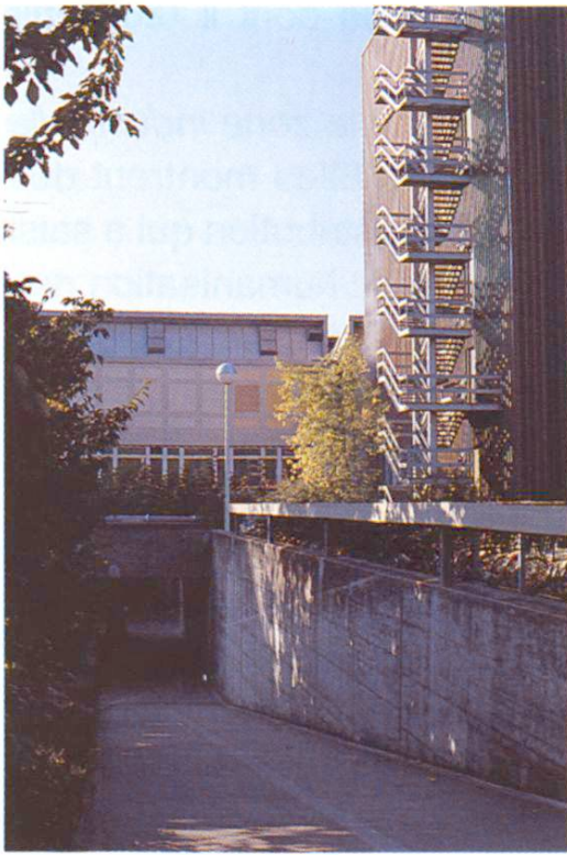
Colorations différentes des façades et des soubassements. (Fabrique de chocolat) 3
