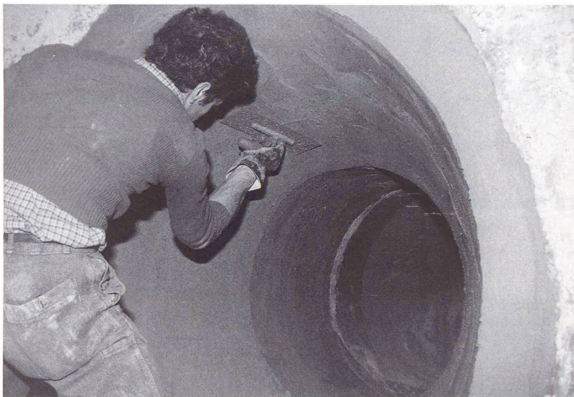
Fig. 7 Application d'un revêtement en mortier de ciment.
