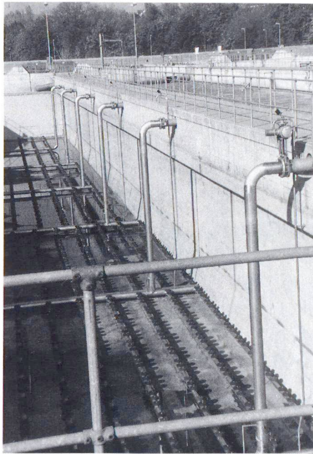
Fig. 11 Vue d'un bassin d'aération. Les matériaux sont le béton et l'acier inox.
