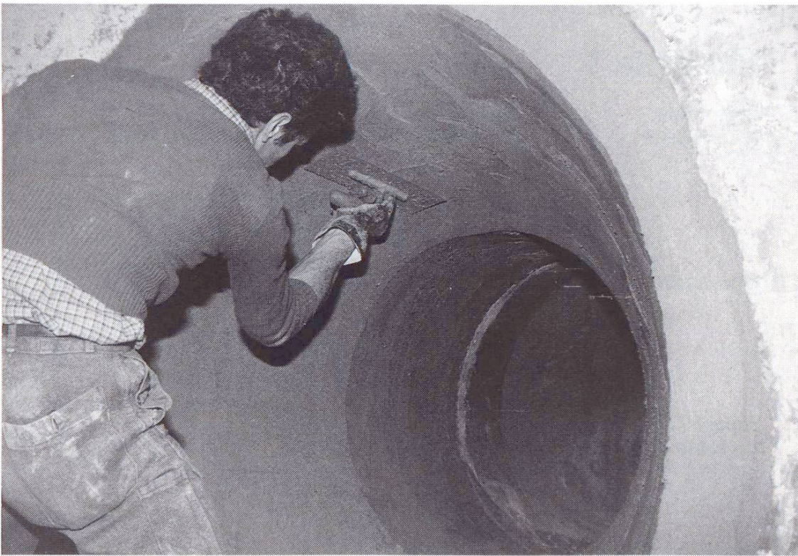
Fig. 7 Application d'un revêtement en mortier de ciment.
