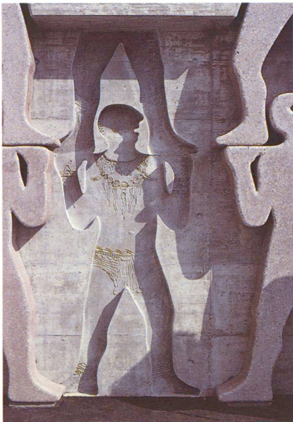
Mur en béton avec relief
