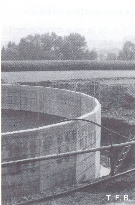
Fig. 13 Avant le remblayage derrière la paroi, on procède à un essai d'étanchéité.
