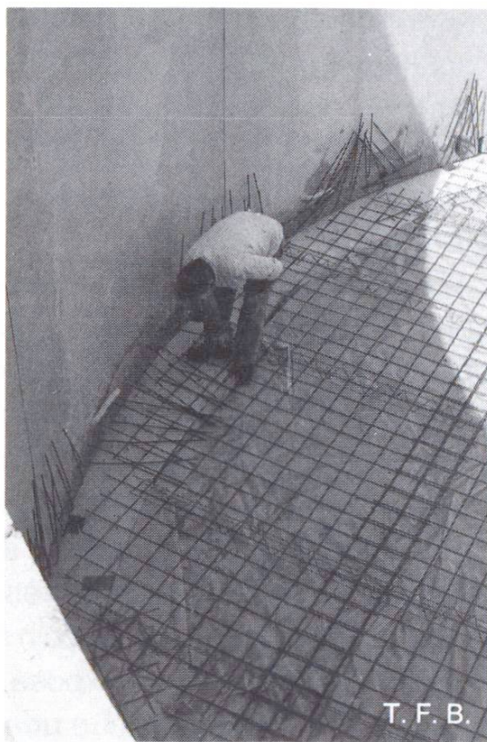
Fig. 11 Pose de l'armature de la dalle de fond puis bétonnage et précontrainte des parois.
