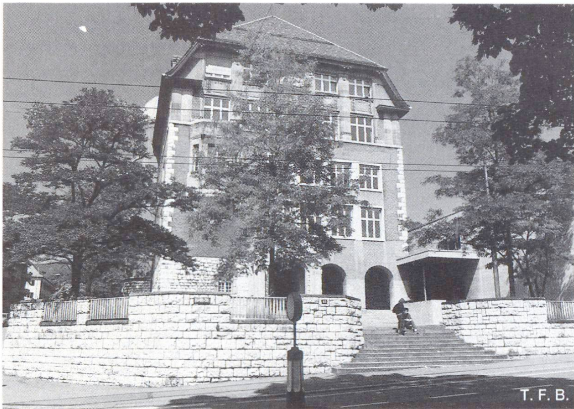
Fig. 7 Les murs de soutènement font partie de l'environnement. En ville ils peuvent être confondus avec les façades des bâtiments (Collège Riedtli, Zurich).
