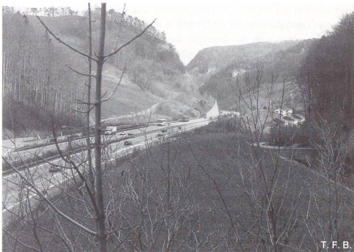
Fig. 5 Pour étudier l'effet optique, il faut considérer les points de vue des différents observateurs (au milieu de la photo, un mur de soutènement tel que le voit un automobiliste, N2 près d'Eptingen).
