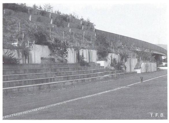
Pour améliorer l'aspect, on peut encore disposer des plages gazonnées (au pied du mur ou en berme à mi-hauteur), utiliser le couronnement, la teinte et la structure de la surface, un revêtement ou encore des plantations. La transition entre le mur et le terrain doit aussi être l'objet d'une attention particulière.
