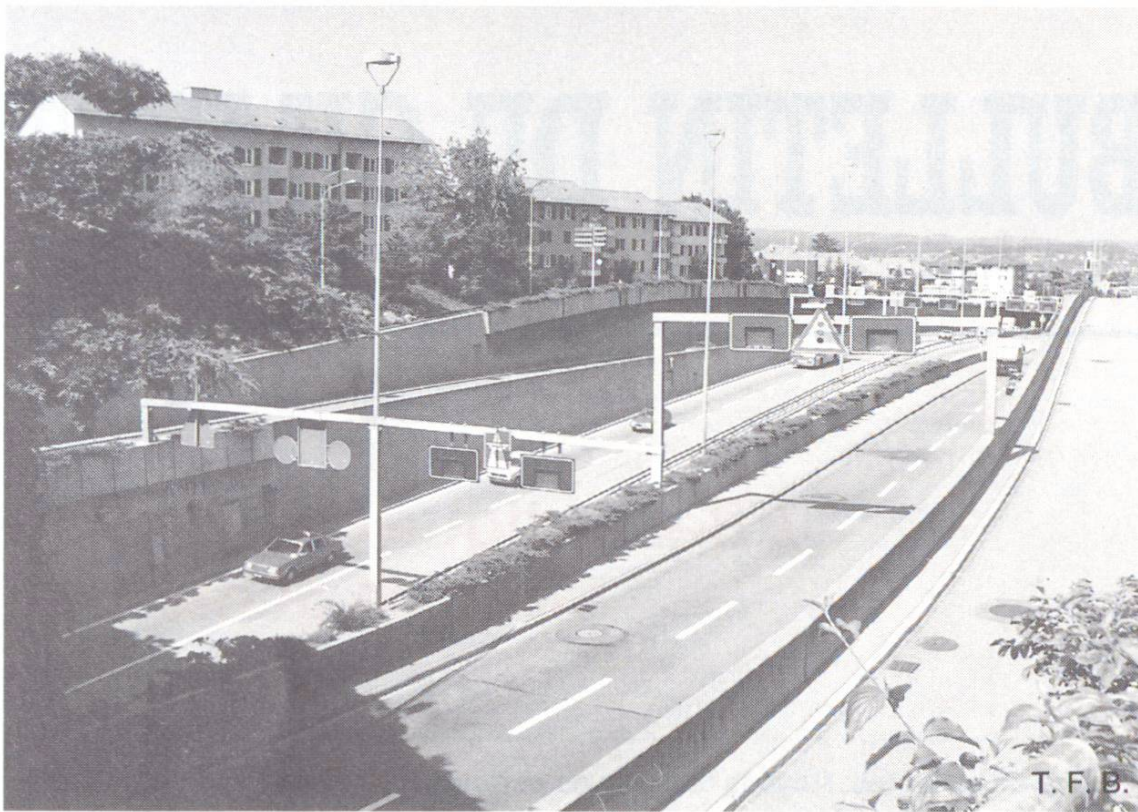
Fig. 1 Les murs de soutènement ne doivent être construits qu'aux endroits où d'autres solutions ne sont pas défendables du point de vue économique (N1 à Zurich, tunnel du Milchbuck, portail nord). Murs de soutènement entre trois voies de trafic étagées.
