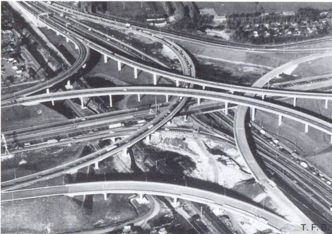
Fig. 6 Croix autoroutière de La Haye (NL). Parapets des ponts exécutés en béton avec MBP.
