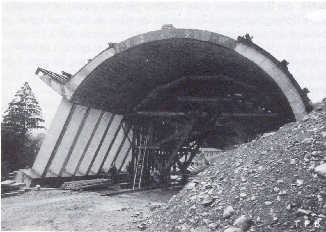
Fig. 5 Tunnel de Spiezwiler (Arge Frutiger, Marti, Lanz). Partie hors de terre au sud. Fondation enterrée sans air occlus. Piliers préfabriqués avec entraîneur d'air. Voûte bétonnée sur place avec adjonction de MBP. Il est actuellement prévu d'exécuter la voûte intérieure du tunnel proprement dit également en béton à air occlus avec adjonction de MBP.
