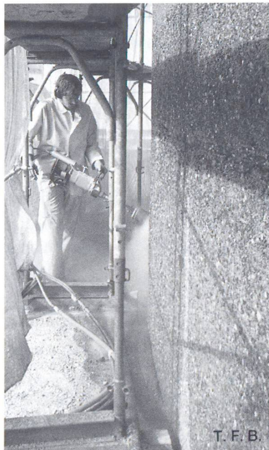
Fig. 4 Enlèvement du béton endommagé au moyen d'eau à haute pression.
