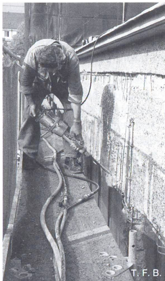
Fig. 5 Repiquage du béton.
