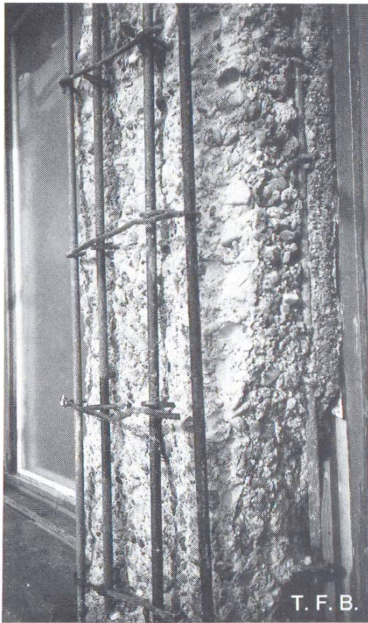
Fig. 6 Pilier prêt à être coffré.
