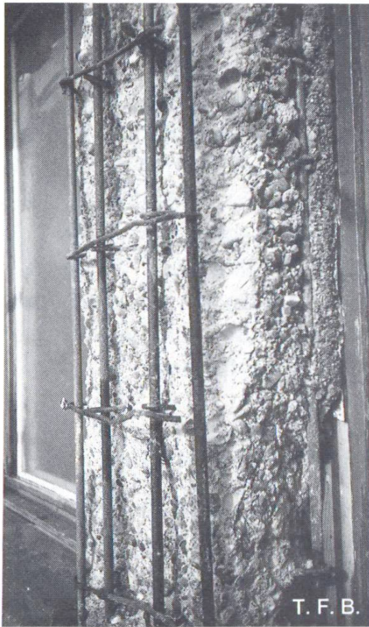
Fig. 6 Pilier prêt à être coffré.
