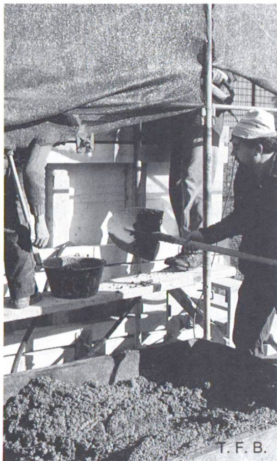
Fig. 8 Béton transvasé de la caisse à mortier au bidon puis au coffrage.
