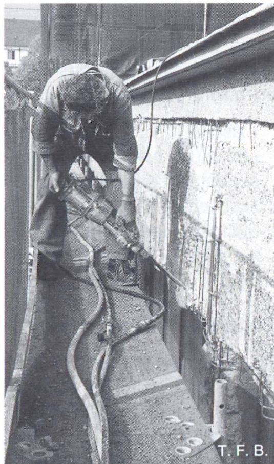
Fig. 5 Repiquage du béton.
