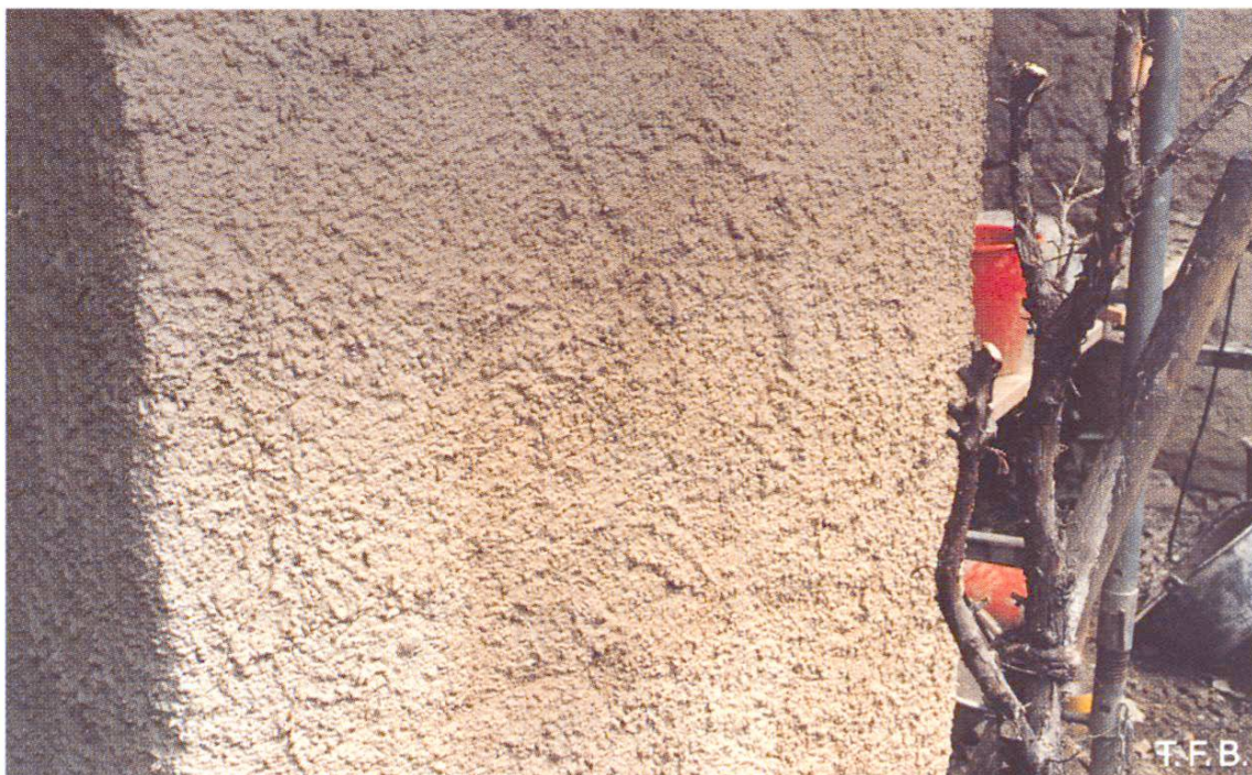
Fig. 8 Couche d'accrochage en mortier 0–8 mm de chaux hydraulique (Pilier en molasse d'une église).
