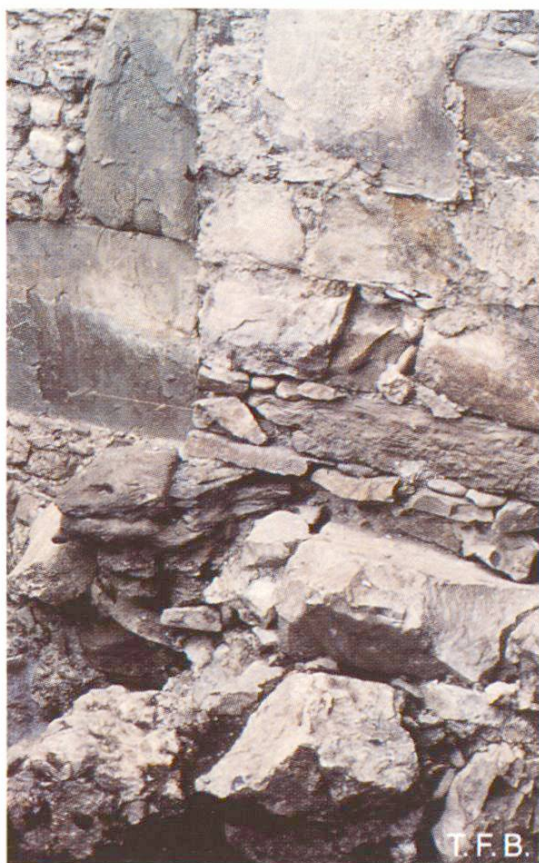
Fig. 20 Face extérieure d'un mur de cave qui a dû être consolidé.
