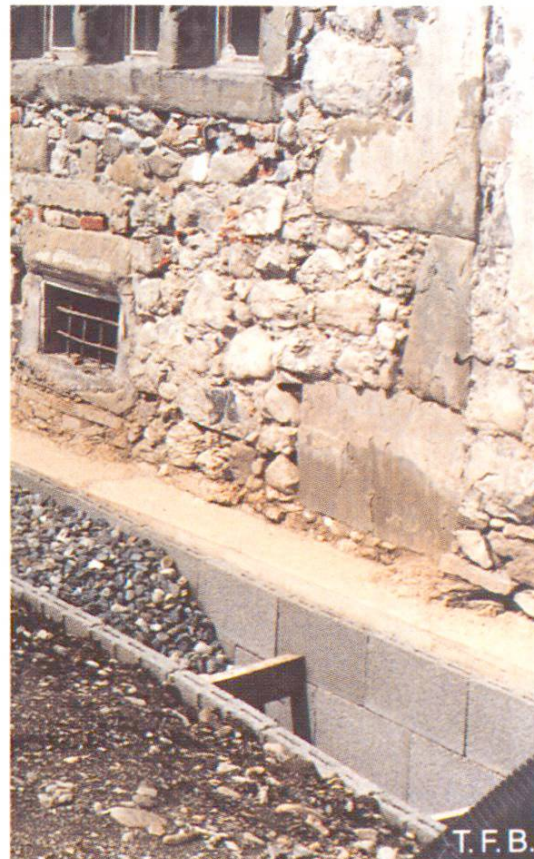
Fig. 21 Le même mur après consolidation au béton fluidifié (chaux hydraulique comme liant). Chemise de drainage selon fig. 19.
