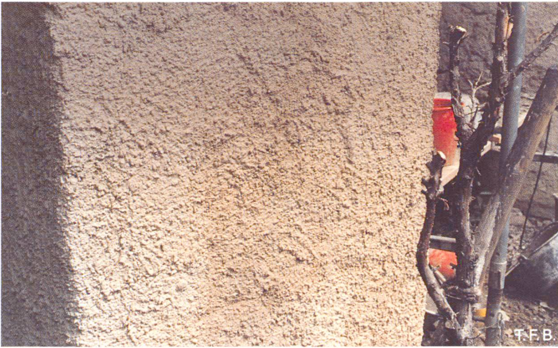
Fig. 8 Couche d'accrochage en mortier 0–8 mm de chaux hydraulique (Pilier en molasse d'une église).
