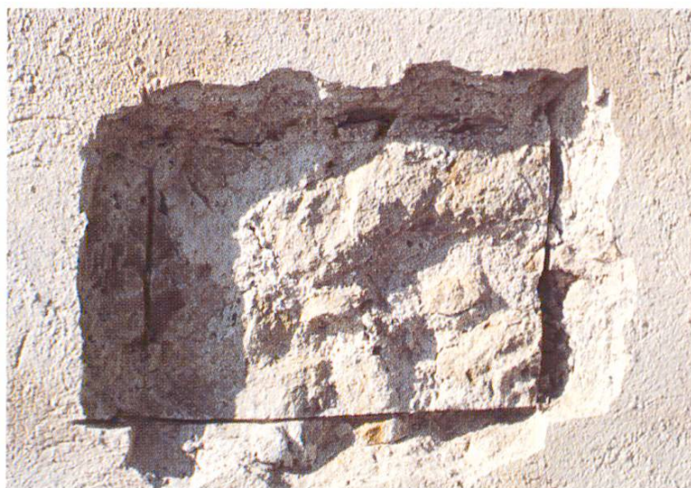
Fig. 9 Après la rénovation, le crépi s'est détaché en plusieurs endroits. Seules quelques traces de mortier ont adhéré à la surface des pierres. Supposition: Couche d'accrochage absente ou pas assez solide et couche projetée trop épaisse.
