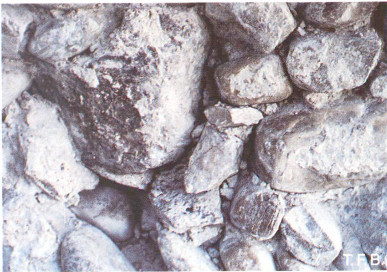
Fig. 7 Le rhabillage de cette maçonnerie mise à nu requiert une grande habileté et beaucoup de soins de la part du maçon (Château de Laupen, partie sud, 1986).
