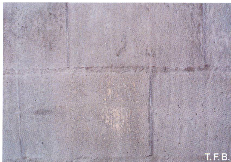
Fig. 10 Cette couche d'accrochage au ciment est comme vitrifiée. La fine couche de mortier au sable fin gachée avec trop d'eau a «eu soif» sur les briques en terre cuite très poreuses. Elle n'a pas pu durcir complètement.
