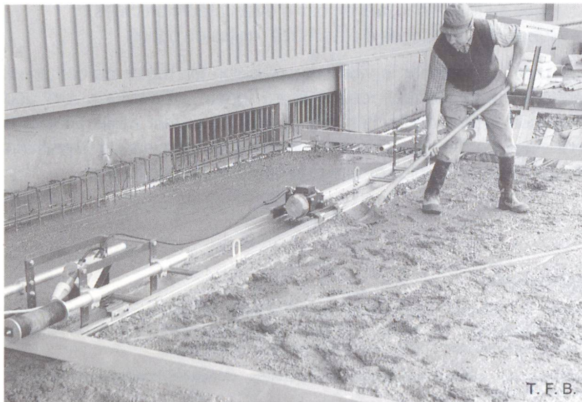
Fig. 1 Réglage de la surface au moyen d'une poutre vibrante.
