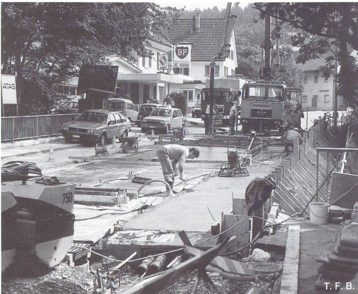
Fig. 5 Pont sur l'Erzbach (AG/SO). Route cantonale à trafic unidirectionnel. Bétonnage de la 2e étape avec traitement par le vide.
