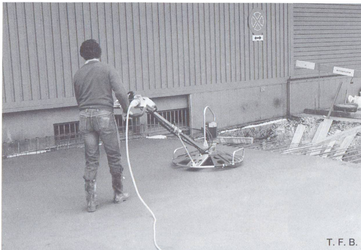
Fig. 3 Finissage de la surface. Talochage mécanique.
