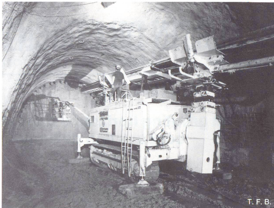
Fig. 1 Avancement en calotte dans un terrain meuble. Foreuse pour le jet grouting.
