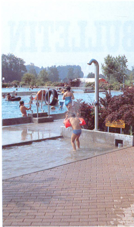
Accès à la zone des bassins par le pediluve (bassin bain de pieds) combiné avec douche (Muri AG)
