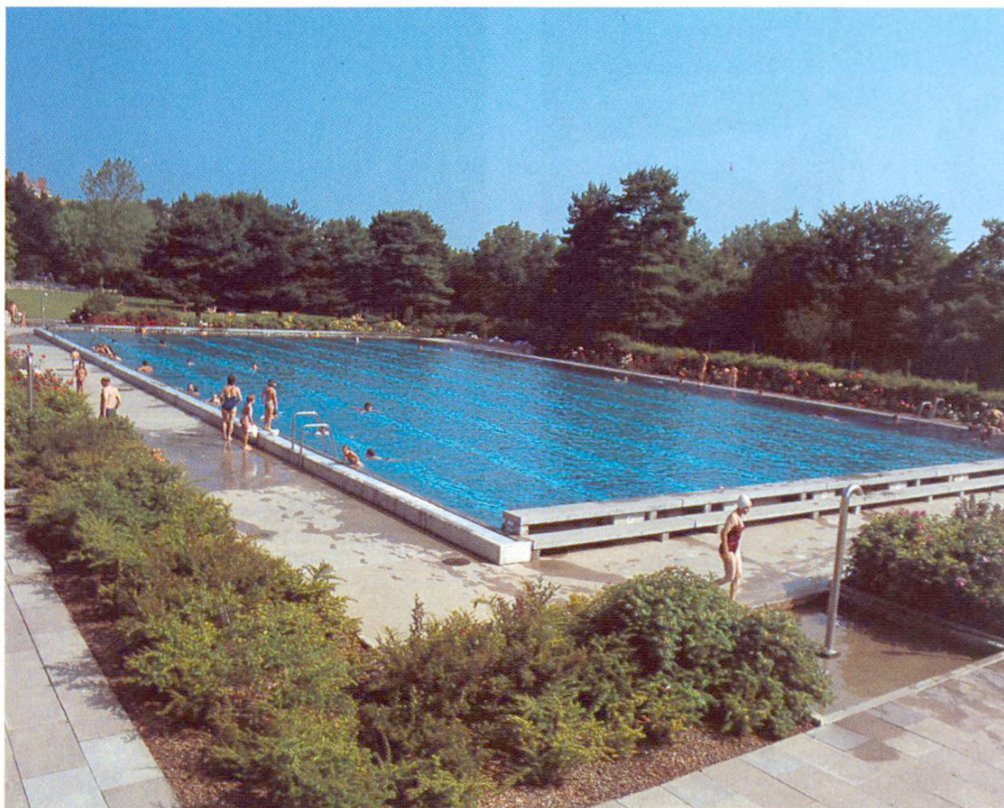
Bassin de natation avec goutte sur les côtés et banquettes de départ aux extrémités (Reinach BL)
