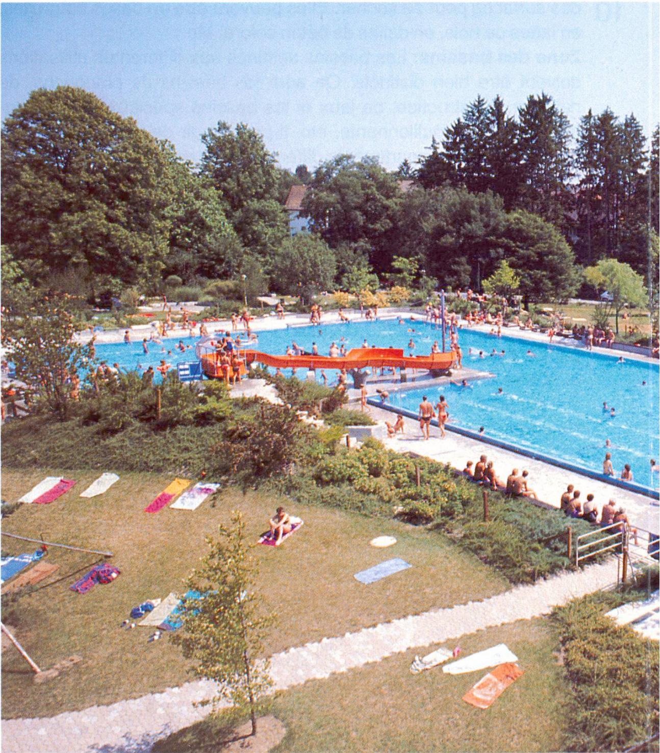
Bassin à usages multiples avec compartiments pour la natation, les jeux et les plongeurs (Wallisellen ZH)
