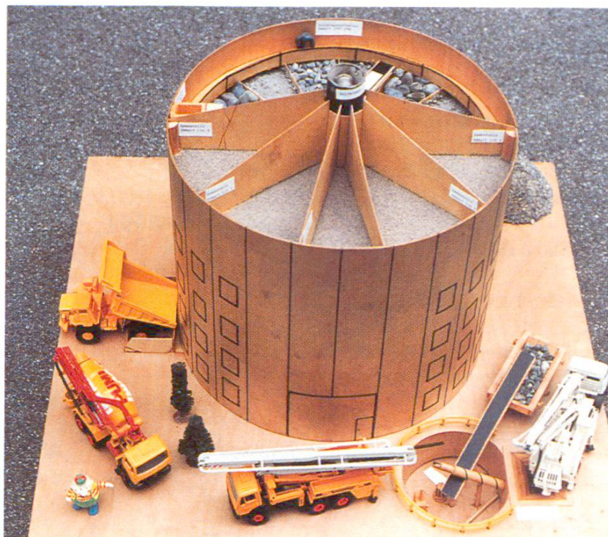
Fig. 3 Modèle réduit. A gauche trémie pour l'amenée des graviers, à droite l'installation de lavage.
