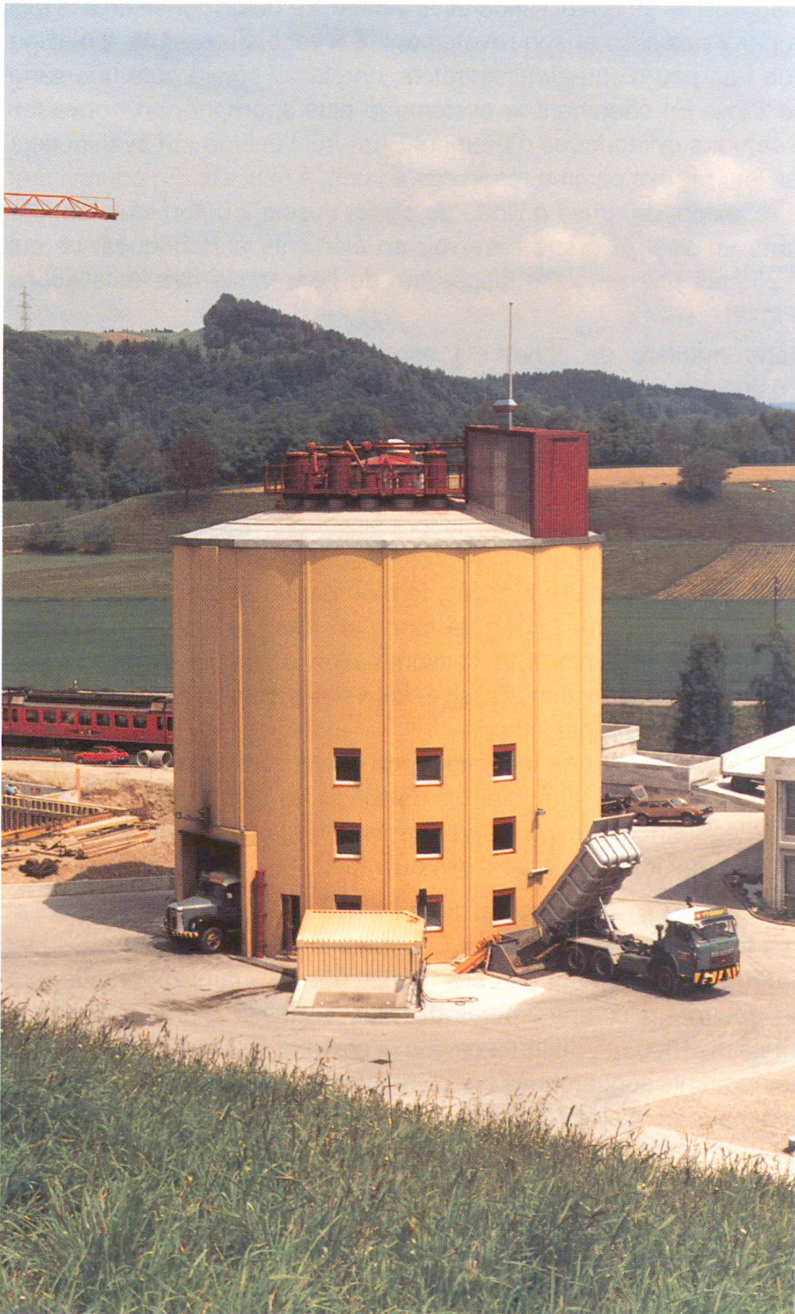
Fig. 10 L'usine en activité. Provisoirement, les graviers sont encore amenés par camion.
