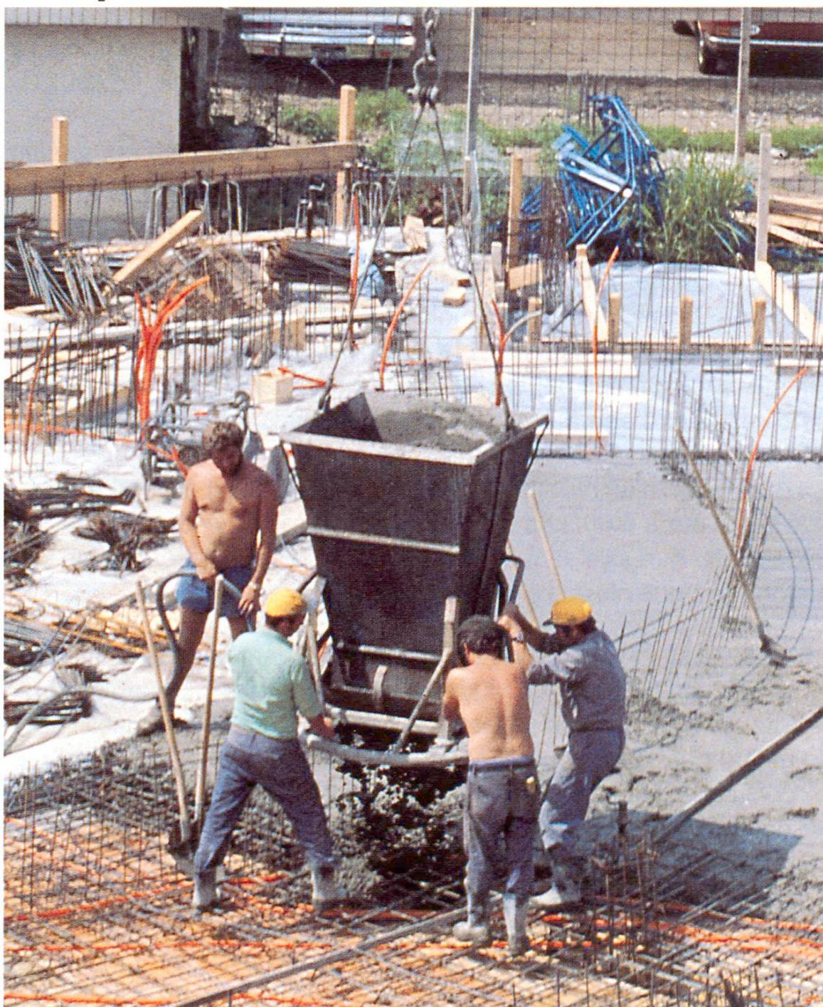
**1** Le **béton** est le résultat d'un mélange de *ciment* et d'un *granulat* composé de sable et de gravier, avec addition d'*eau*. Normalement, 1 m<sup>3</sup> de béton comporte 300–350 kg de ciment, environ 2000 kg de *granulat* et 130–200 l d'*eau*, plus, suivant l'utilisation prévue, de petites quantités d'autres produits (adjuvants: environ 0,5–10,0 kg/m<sup>3</sup>; ajouts: environ 5–50 kg/m<sup>3</sup>). Après le gâchage, le béton doit être mis en place et compacté en peu de temps.
