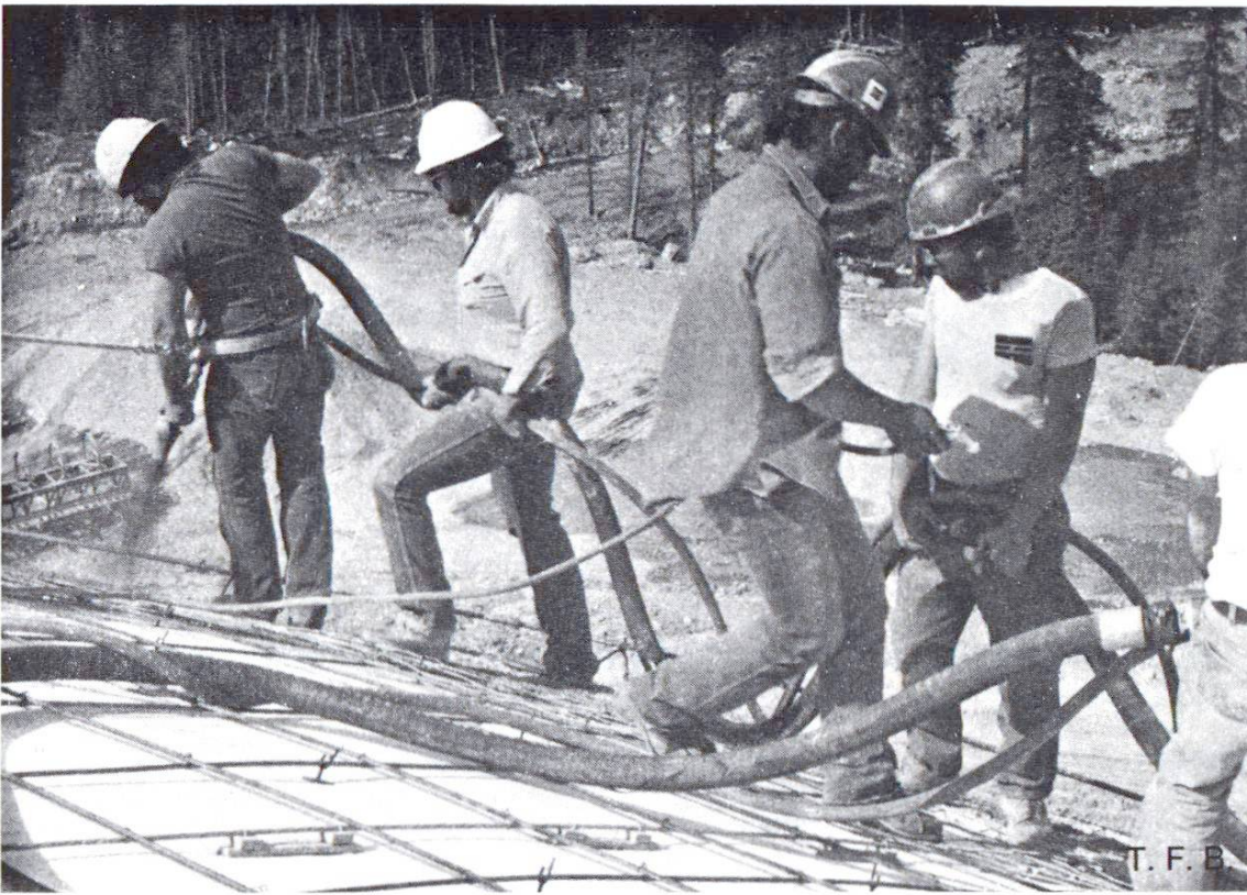
Fig. 8 Détail de la mise en œuvre du béton projeté.
