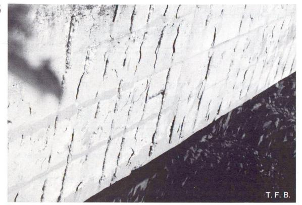
Fig. 6 Dégâts provoqués par la rouille sur un parapet de balcon, à cause de la carbonatation du béton.
