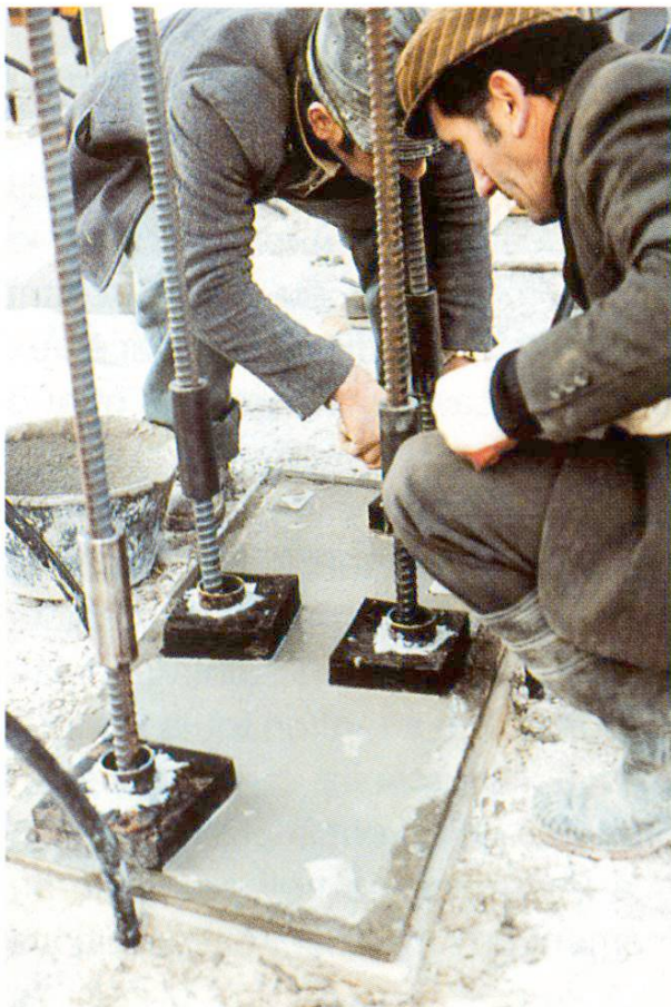
Ancrage des colonnes dans le sol. Précontrainte: Spann-Stahl AG, Hinwil.
