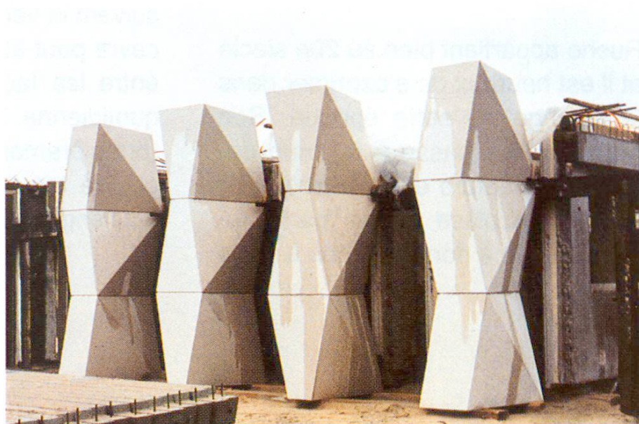
Eléments types A et B prêts pour le transport sur le chantier. 7
