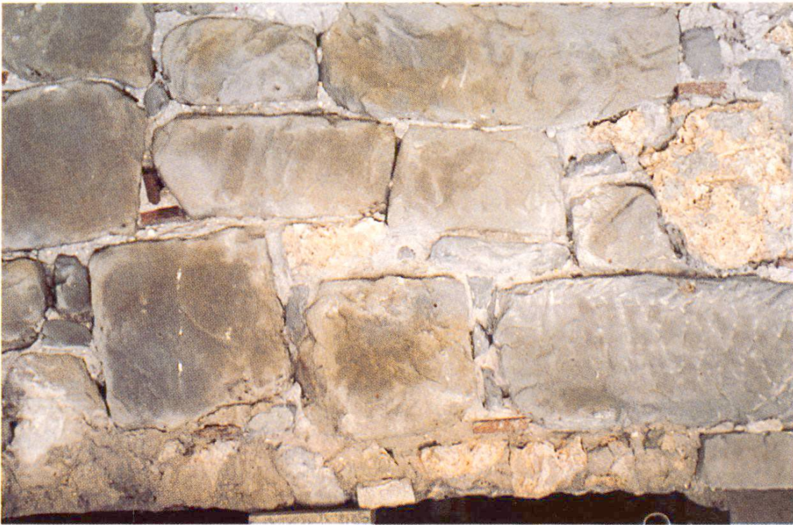
Fig. 3 La maçonnerie mixte a été rejointoyée et crépie.
