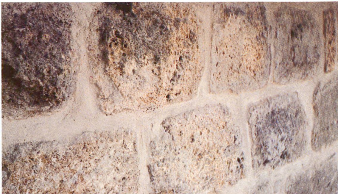
Fig. 8 La teinte du mortier est adaptée à celle des blocs de tuf. On a utilisé dans ce but du sable moulu de la carrière de calcaire d'Egerkingen. On remarquera la compacité du mortier qui adhère parfaitement aux blocs, sans aucune fissure.
