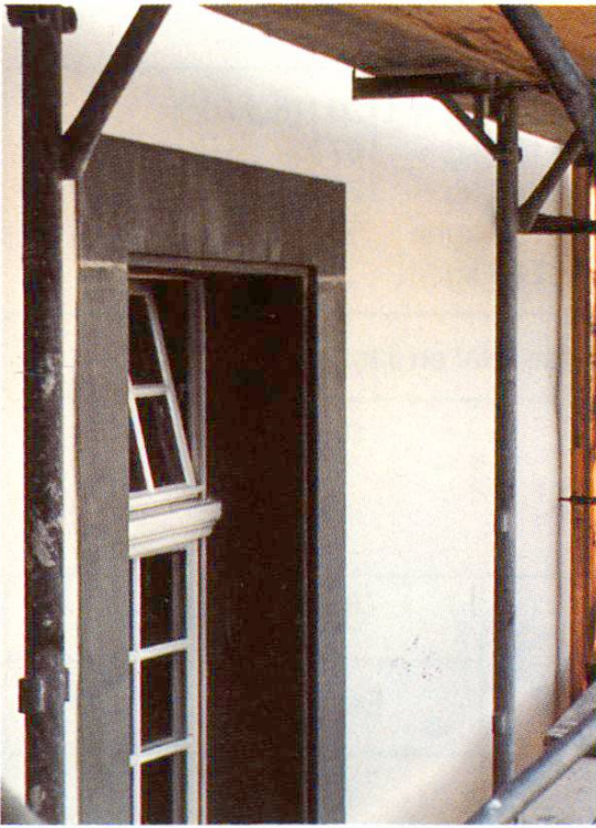
Fig. 4 Détail de la façade nord. Cadre de fenêtre rénové et nouveau crépi peint.
