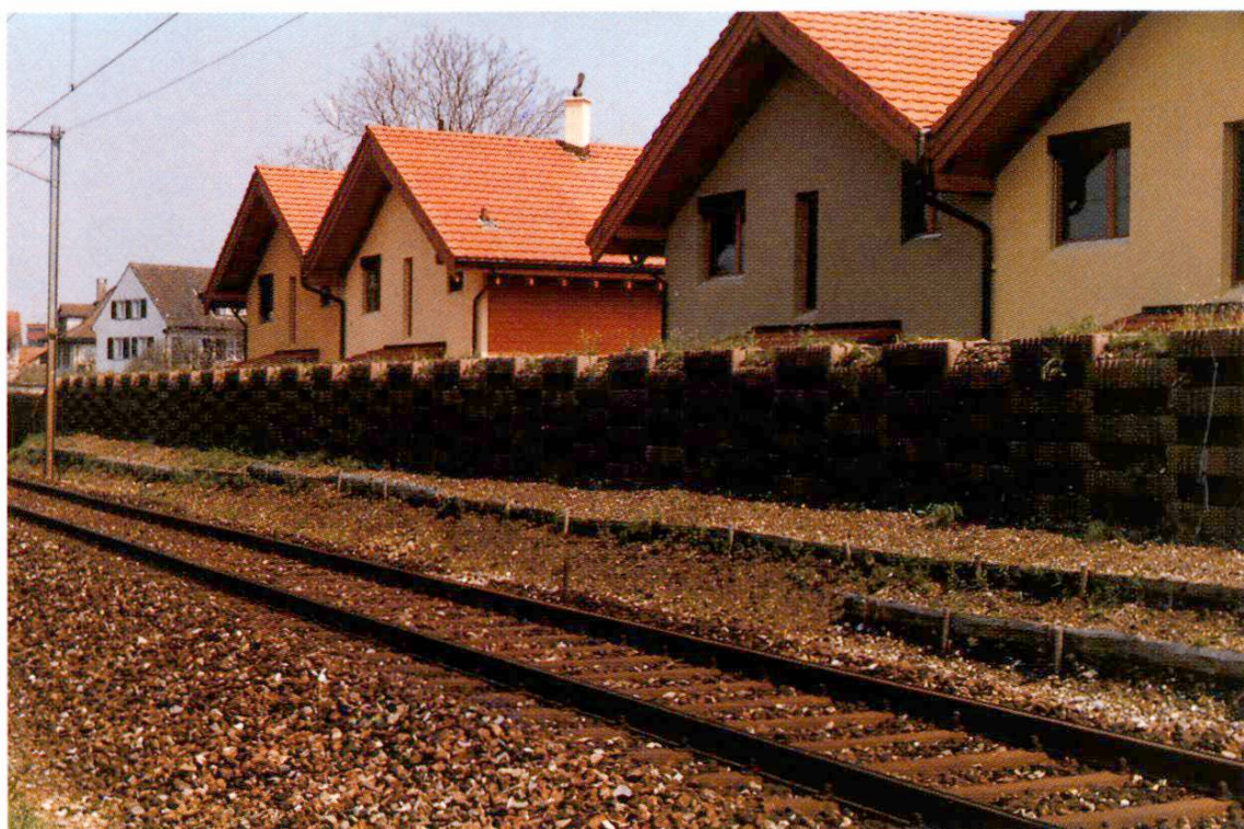
Fig. 4 Paroi antibruit entre une rangée de maisons et une voie de chemin de fer. Type S en éléments de 100 \times 20 \times 60 cm et 160 kg.
