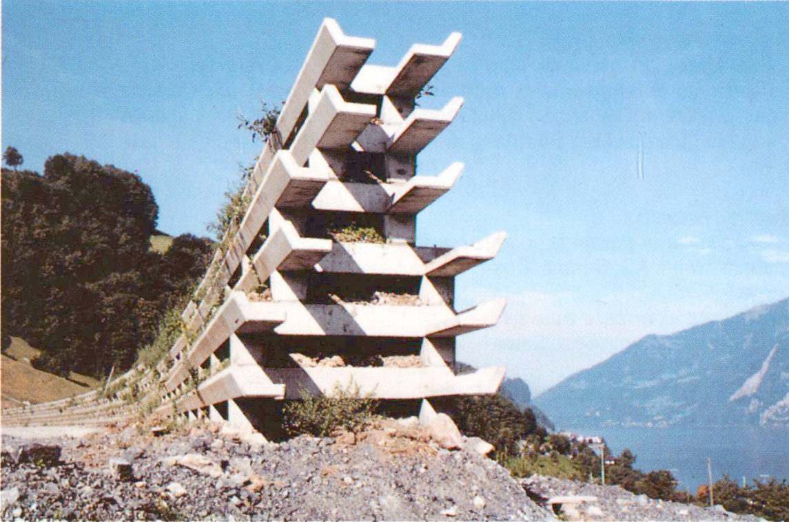
Fig. 1 Paroi antibruit sans autre fonction (Chantier N3 près de Mühlehorn).
