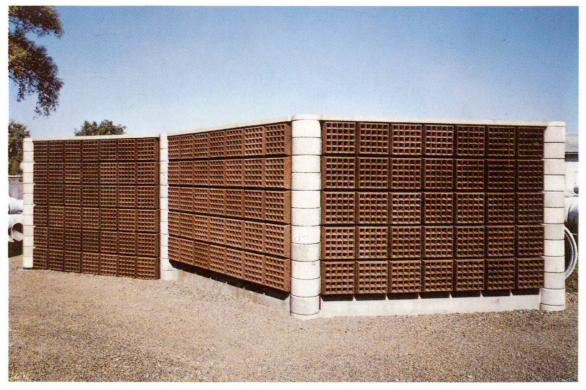
Fig. 10 En plan, ligne brisée offrant un meilleur aspect esthétique. Des montants en tube métallique espacés de 3,93 m, placés sur fondations individuelles, supportent des éléments horizontaux (h=50 cm) munis à leurs extrémités d'anneaux de fixation en béton (h=25 cm).
