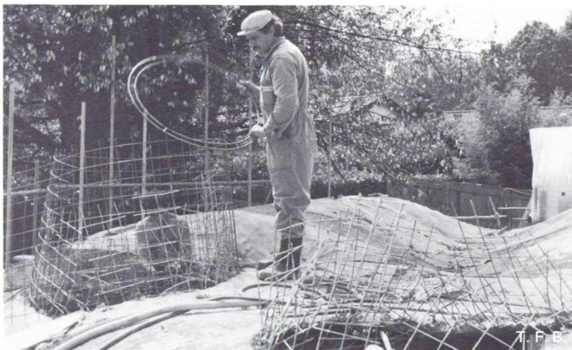
Fig. 6 Raccordement aux coupôles transparentes. La première couche de béton a été brisée et on met en place l'armature du «cratère» avec un anneau métallique sur lequel viendra se fixer la coupole. Ensuite, les autres couches de béton pourront être projetées.
