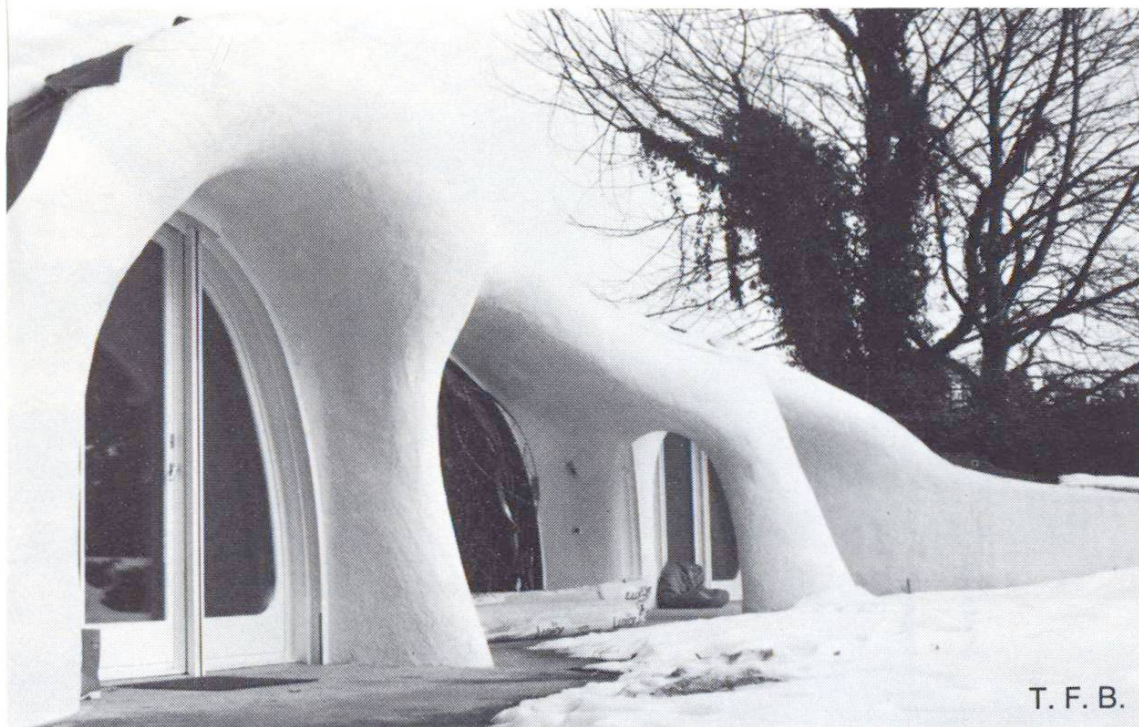
Fig. 8 Isolation extérieure en polyuréthane qui permet en outre de réaliser les formes définitives. Peinture des parties restant visibles.
