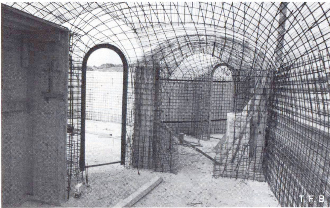
Fig. 3 Façonnage des parois et plafonds avec des fers croisés ou des treillis. Mise en place des cadres de portes et fenêtres ainsi que des niches.
