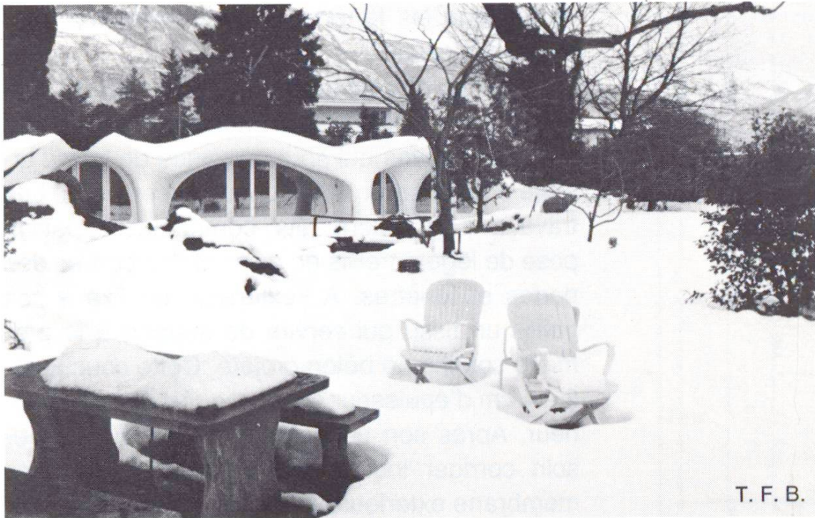
Fig. 9 Vue d'une maison familiale en béton projeté recouverte de terre.
