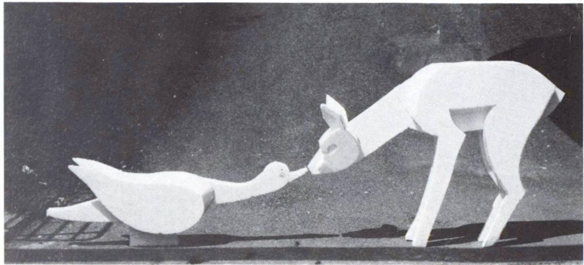
Coffrage constitué de plaques de Styropore de 4–6 cm d'épaisseur. Les formes découpées peuvent être assemblées en un modèle à l'échelle 1:1. Les négatifs sont légèrement collés sur des planches de coffrage. Une armature est mise en place.
