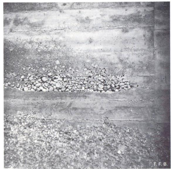
Fig. 4 Ségrégation dans un béton.
