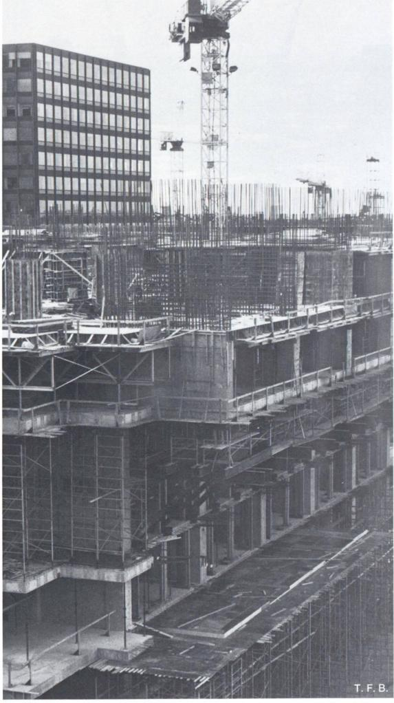
Fig. 3 Construction des parois raidissantes au 14° étage. L'encorbellement est supporté provisoirement par un étayage métallique.
