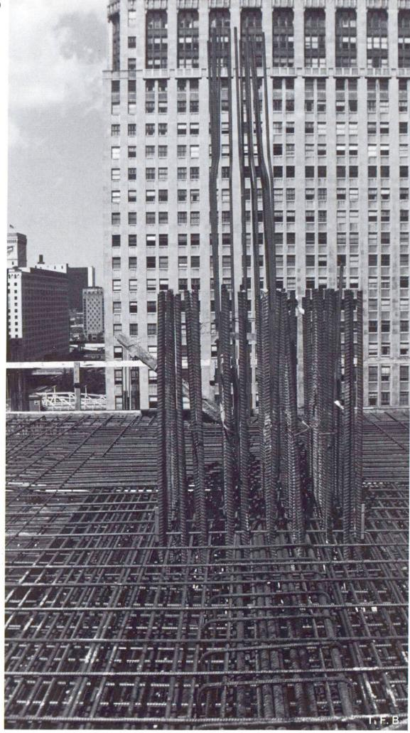
Fig. 4 Armature d'un pilier principal et de la traverse qui le relie à la paroi intérieure au 9° étage.
