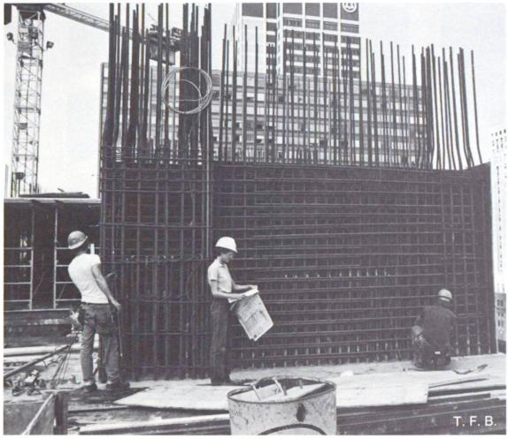
Fig. 6 Contrôle de l'armature.
