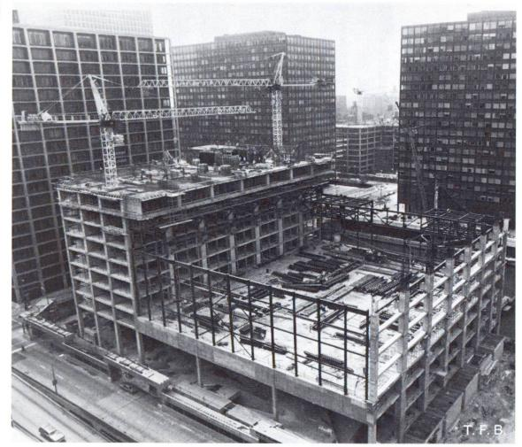
Fig. 8 Vue du chantier avec la tour l'jusqu'au  $9^{\rm e}$  étage et la grande salle pour la bourse avec ses 3700 m² occupant plus de la moitié de la surface du terrain.
