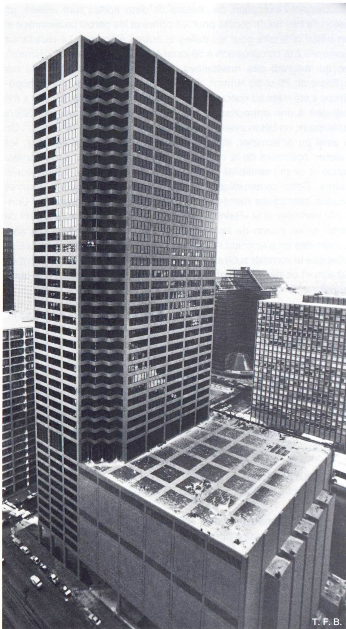
Fig. 10 Le bâtiment en décembre 1983 après achèvement de la première phase.
