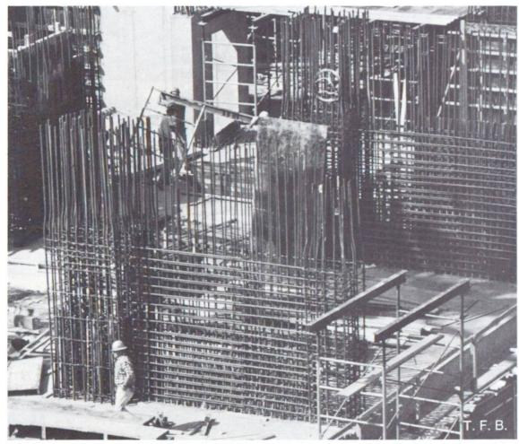
Fig. 5 Armature des parois raidissantes du  $10^{\rm e}$  étage. A l'arrière, partie du système de parois contre les efforts latéraux. Aciers d'armature  $\varnothing$  36 mm.
