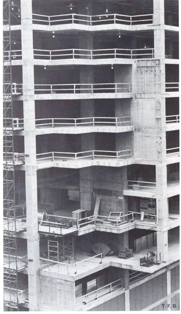
Fig. 7 Vue des parois raidissantes des étages 9 à 15. Les colonnes extérieures tendues des étages 10 à 12 et les parties de dalles qu'elles supportent seront exécutées ultérieurement.
