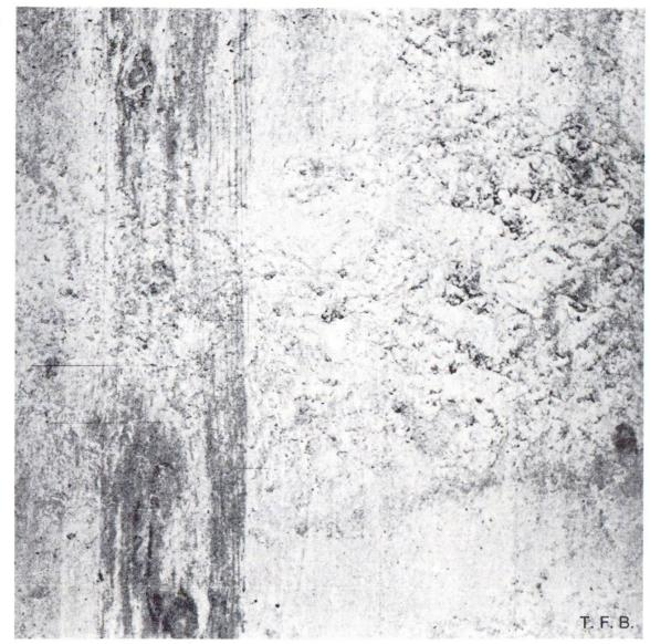
Fig. 3 Ségrégation dans un mélange trop pauvre en sable, impropre à donner un béton apparent satisfaisant.
