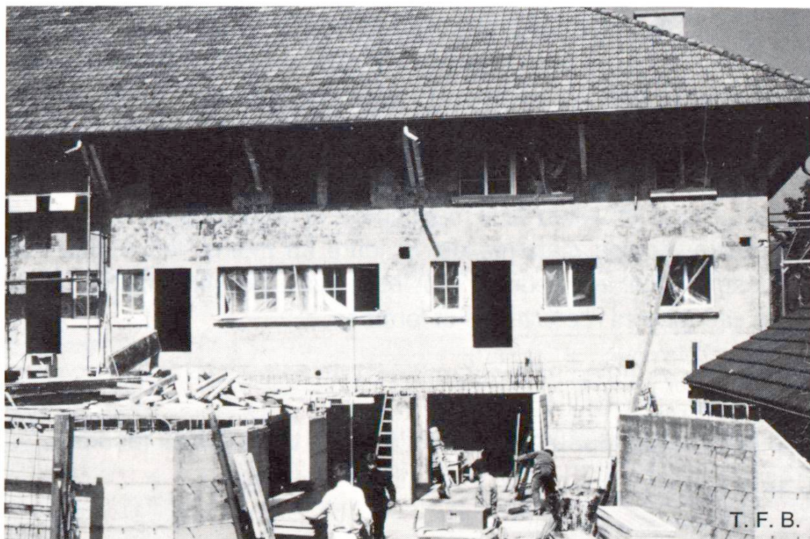
Fig. 1 Le support du crépi — ici une maçonnerie en briques cuites — est pourvu d'une première couche de ciment qui, après durcissement, recevra le crépi de fond à la chaux.
