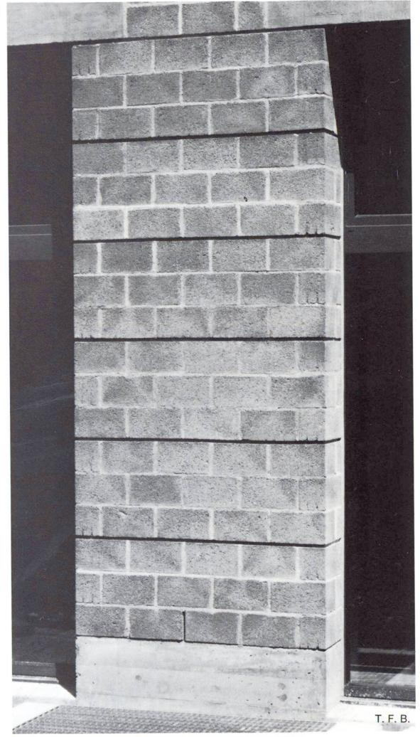
Fig. 8 Maçonnerie apparente en béton dans un assemblage spécial.
