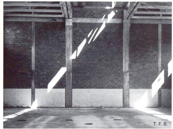
Fig. 6 Maçonnerie apparente en béton dans une usine.
