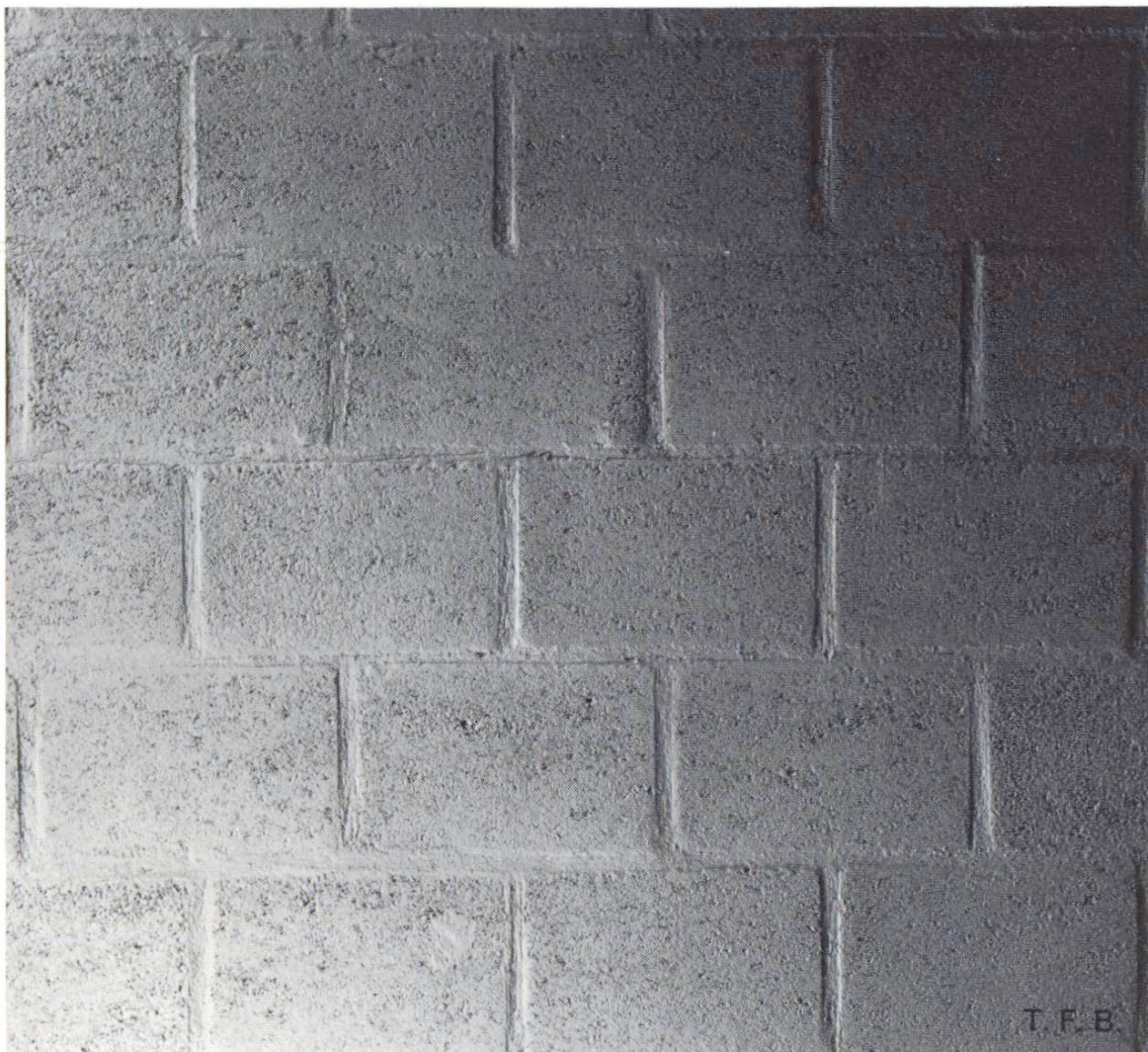
Fig. 9 La structure de surface de briques de béton crée entre celles-ci des différences de teinte qui animent agréablement la façade.
