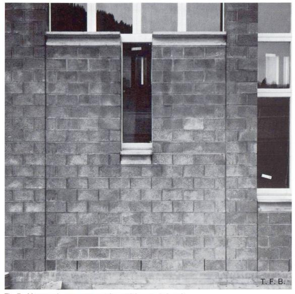
Fig. 7 Maçonnerie apparente en béton d'éléments de façade.
