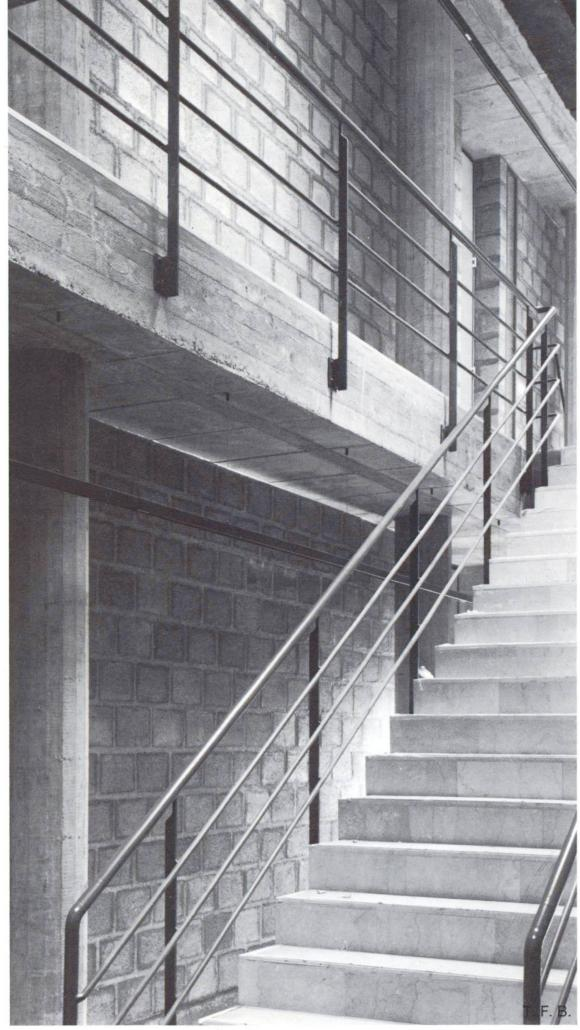
Fig. 5 Maçonnerie apparente en béton pour le bâtiment de la direction d'une fabrique.
