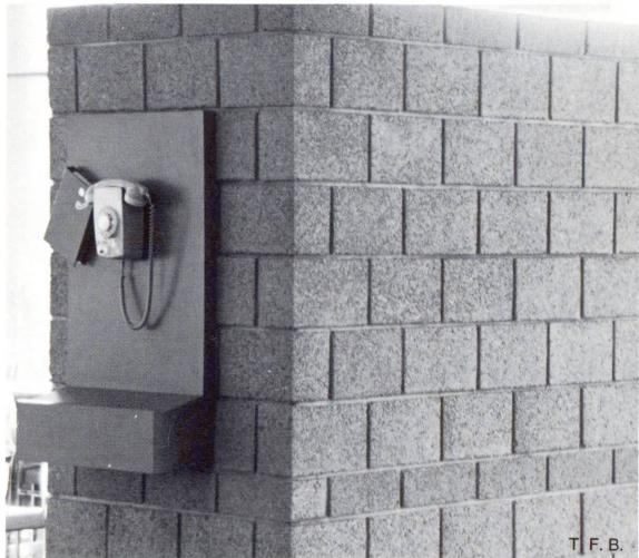
Fig. 11 Maçonnerie apparente en béton pour paroi de séparation.
