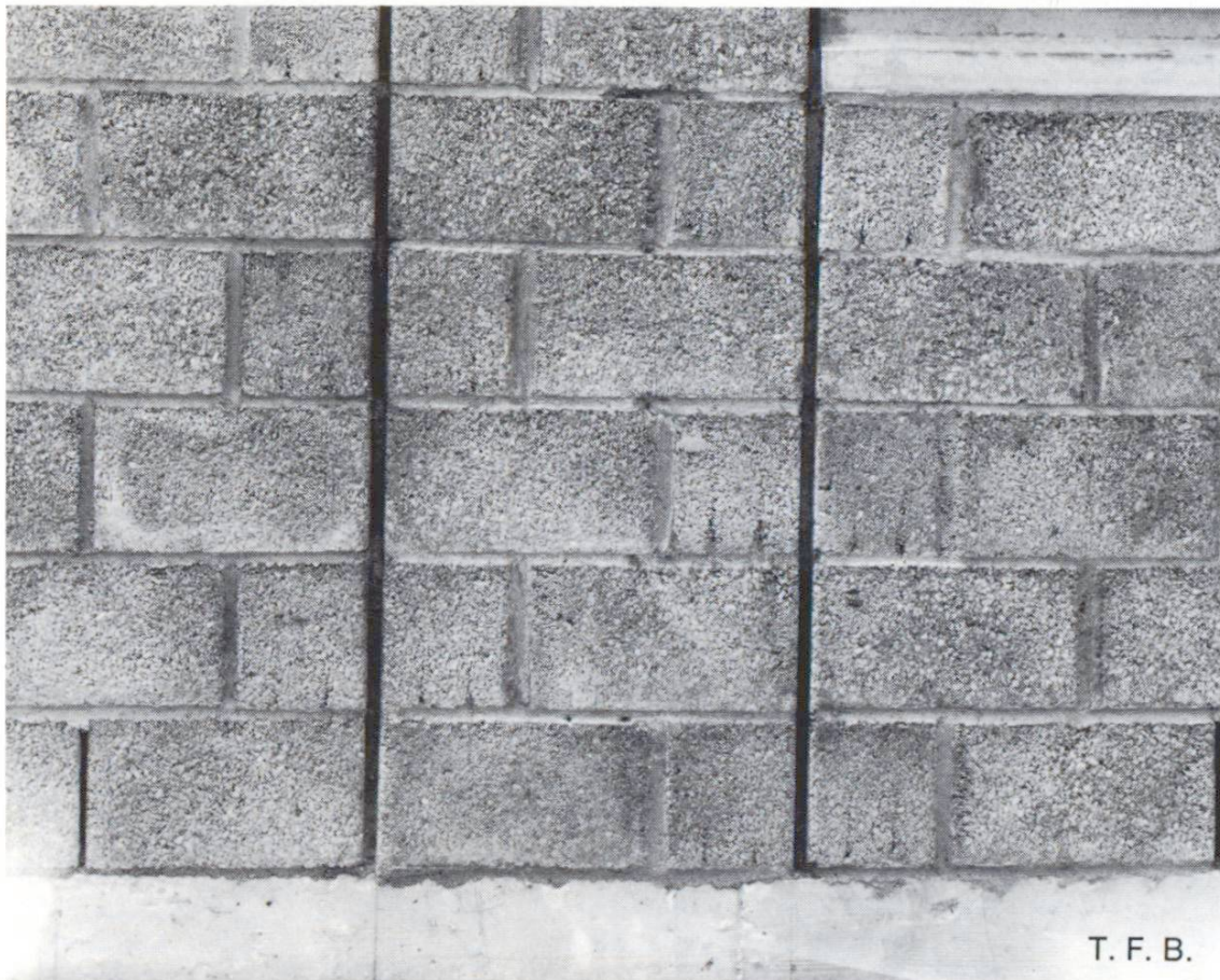
Fig. 10 Maçonnerie apparente en béton avec légère teinture en dispersion.
