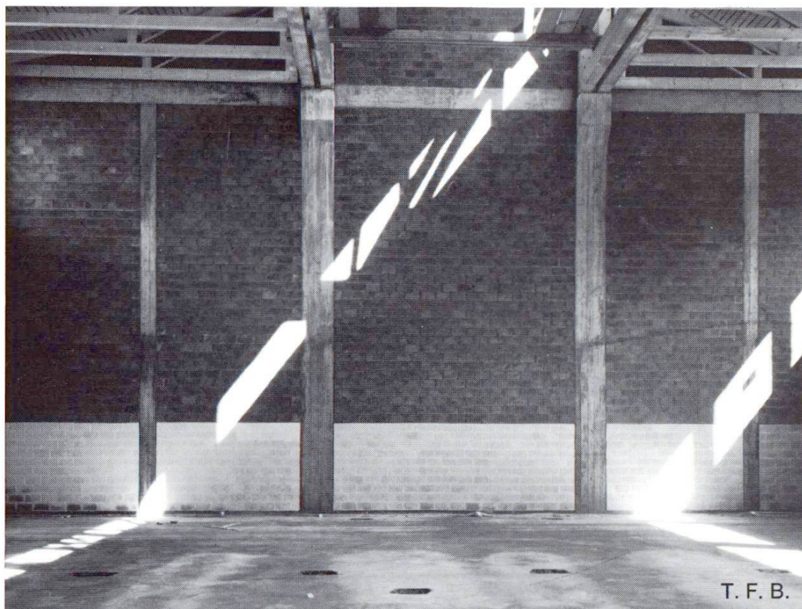
Fig. 6 Maçonnerie apparente en béton dans une usine.
