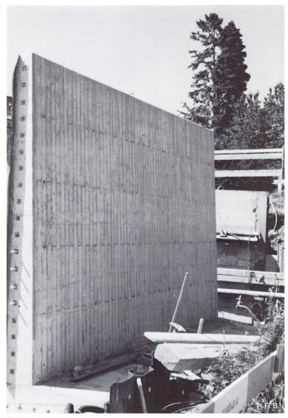
Fig. 9 Haut mur de soutènement en béton apparent de très bel aspect.
