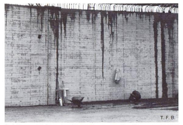
Fig. 8 Grande surface d'un mur de soutènement obtenue au moyen d'un coffrage en panneaux à joints systématiquement décalés et formés de planches bien visibles. Cela donne l'image d'un véritable béton apparent classique coffré en planches.
