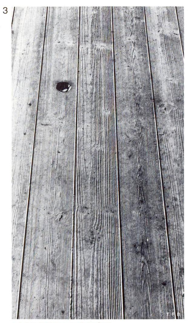
Fig. 2 Surface du béton obtenu par le coffrage de la figure 1.
