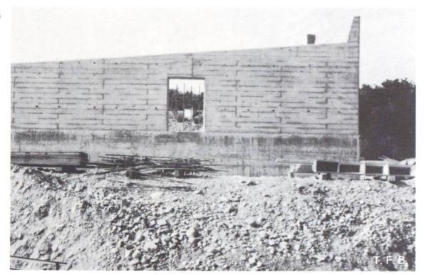
Fig. 5 Béton apparent obtenu au moyen d'un coffrage en panneaux à joints décalés.
