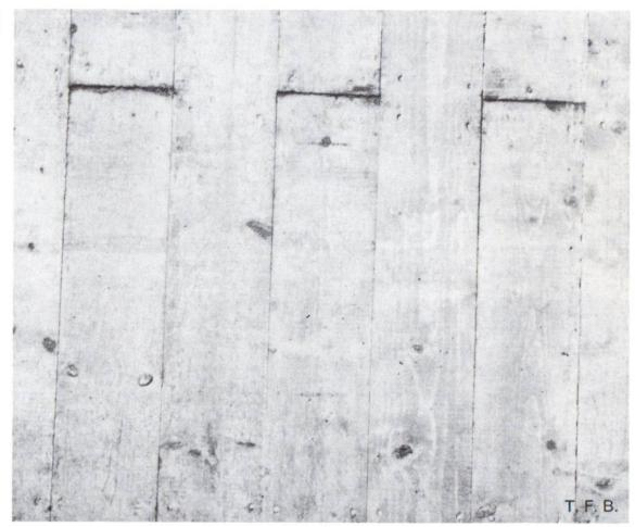
Fig. 3 Béton obtenu au moyen d'un coffrage en panneaux de planches rabotées. Les panneaux sont constitués de planches clouées avec joints à rainure et languette.
