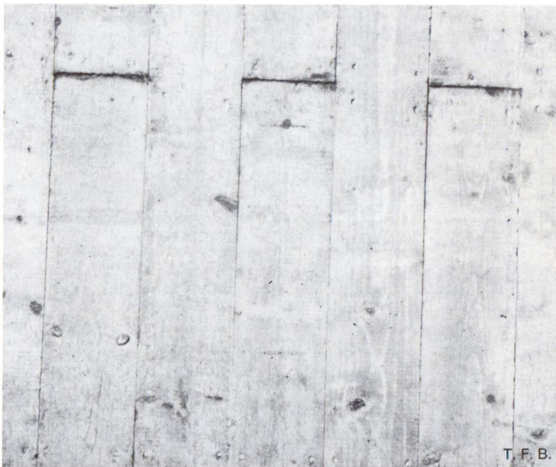
Fig. 3 Béton obtenu au moyen d'un coffrage en panneaux de planches rabotées. Les panneaux sont constitués de planches clouées avec joints à rainure et languette.
