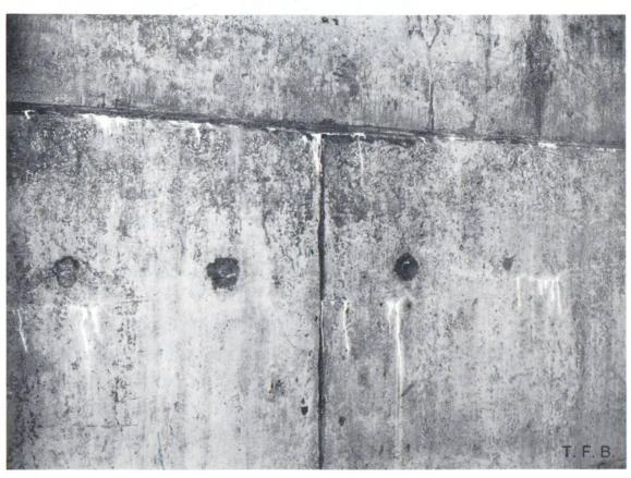
11. Calcification d'un joint de reprise et de fissures de retrait
