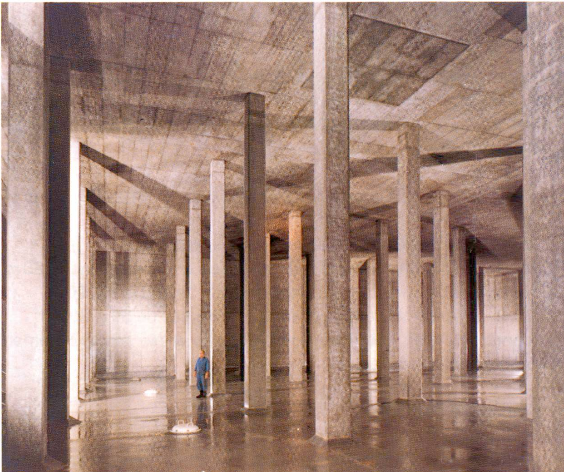
Réservoir d'eau potable en béton apparent étanche
