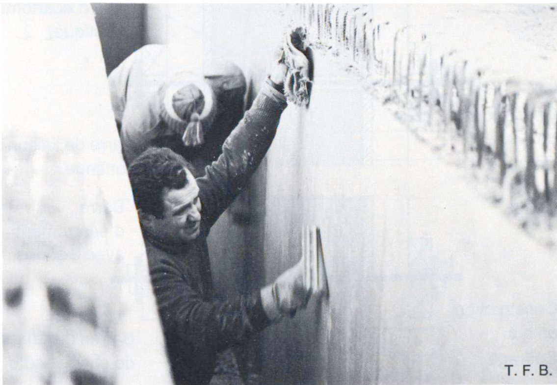
10. Traitement de surface au chiffon
