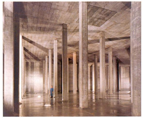
Réservoir d'eau potable en béton apparent étanche
