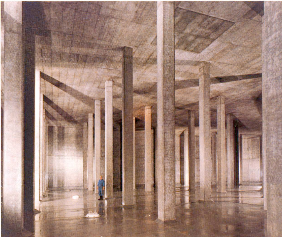
Réservoir d'eau potable en béton apparent étanche
