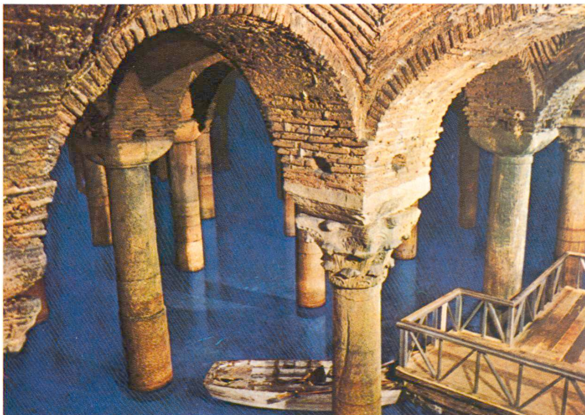
Ancien réservoir d'eau potable à Istanbul datant des années 530, contenance 70 000 m 3
