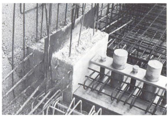
9. Détail d'un joint de reprise avec tôle d'étanchéité
